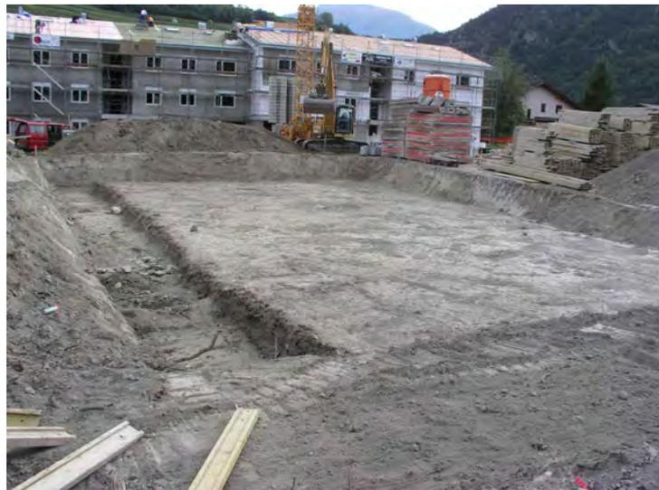
**Fig. 8.** Bramois/Pranoé C. Vue générale du chantier et de la tranchée pare-gel. Vue depuis le nord.
