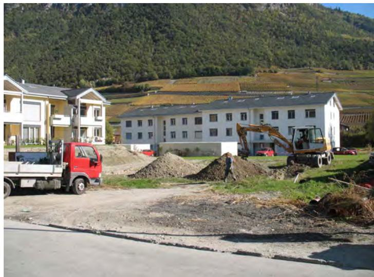
**Fig. 9.** Bramois/Pranoé D. Sondages exploratoires en cours avant le début des travaux de terrassement. Vue depuis l'ouest.
