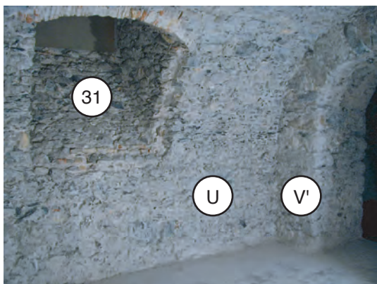
cave Z, paroi ouest avec percement de la fenêtre (31)
