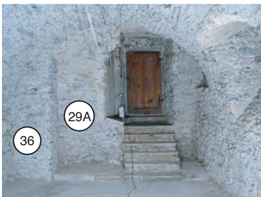
cave Z, paroi sud avec pilier 36 et maçonnerie 29A (escaliers en colimaçon)
