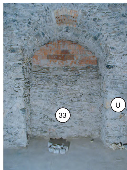
cave Y, paroi ouest, détail de l'ancienne porte d'entrée transformée en fenêtre, puis bouchée complètement
