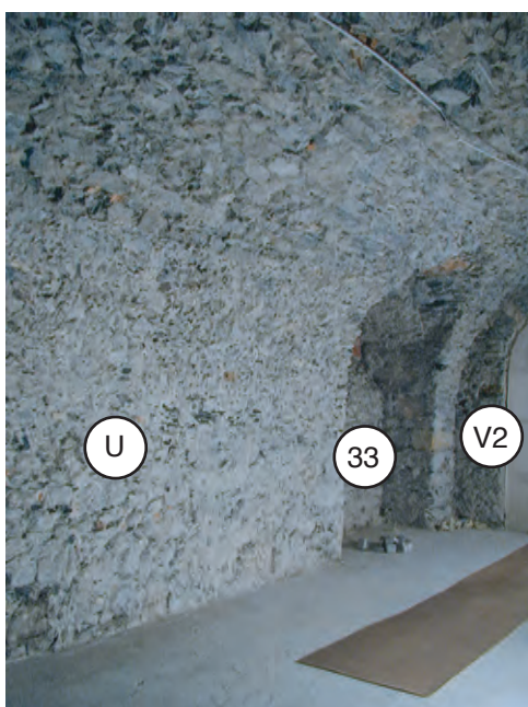
cave Y, paroi ouest avec emplacement de l'entrée originale
