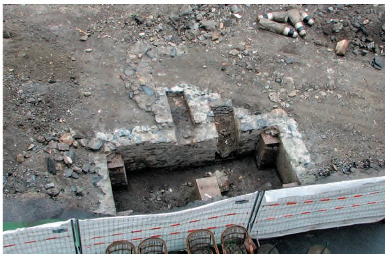
**Fig. 63** Poids public après son dégagement, vu de l'ouest. On distingue les socles aménagés dans les angles et contre l'une des parois de la fosse. Derrière les deux niches saillantes apparaissent les fondations liées au ciment d'un soubassement circulaire plus récent.
