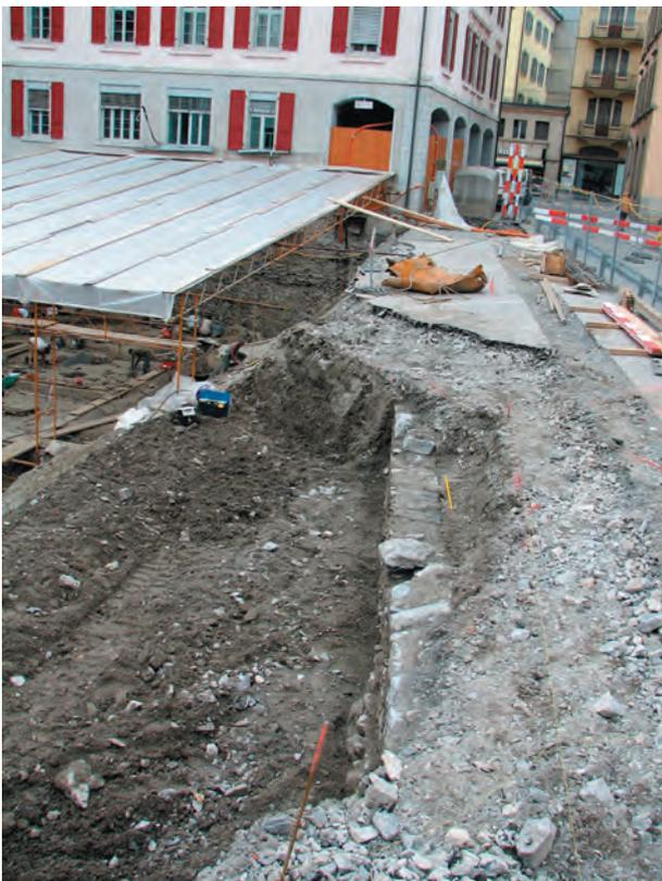
**Fig. 49** Mur longeant le bord de l'excavation pour le parking, vue du sud. Maçonnerie liée au ciment (UT805) axé sur l'angle sud-est du bâtiment de l'édilité.
