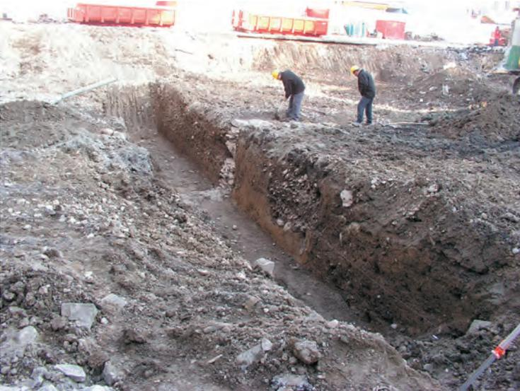
**Fig. 5** Tranchée 1, première étape, vue du nord-ouest. La maçonnerie visible en coupe correspond au bord extérieur du fossé médiéval (mur de contrescarpe).
