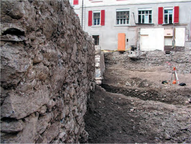
**Fig. 23** Le parement du mur de contrescarpe, vu vers le nord. Au premier plan, il apparaît vertical, plus au nord, incliné.
