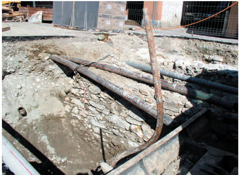
**Fig. 34** Parement occidental du mur épais (UT871) dégagé dans un sondage, vue du sud-ouest. L'arase du mur avait été entaillé pour la pose d'anciennes canalisations ; pour les exigences du chantier en cours, elle a dû être abaissée davantage.
