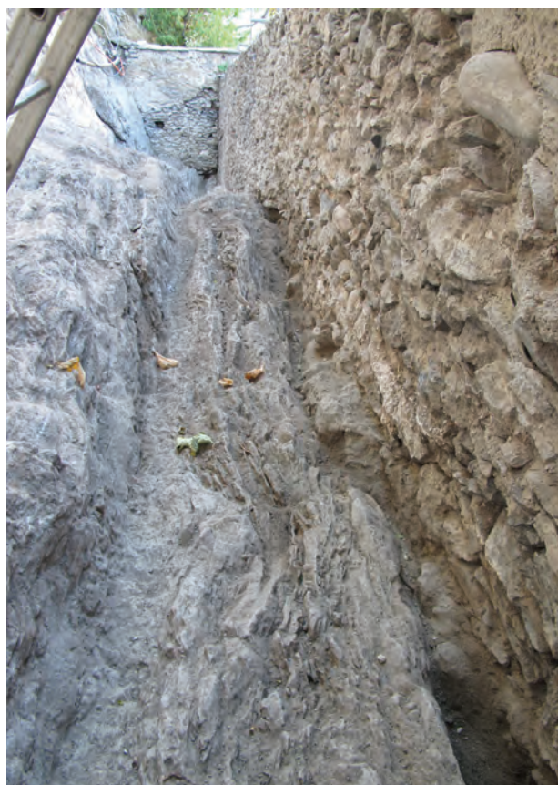
Fig. 8B. Sion, Majorie. Espace au nord de la galerie d'accès orientale. Détail du drain. Vue vers l'est.
