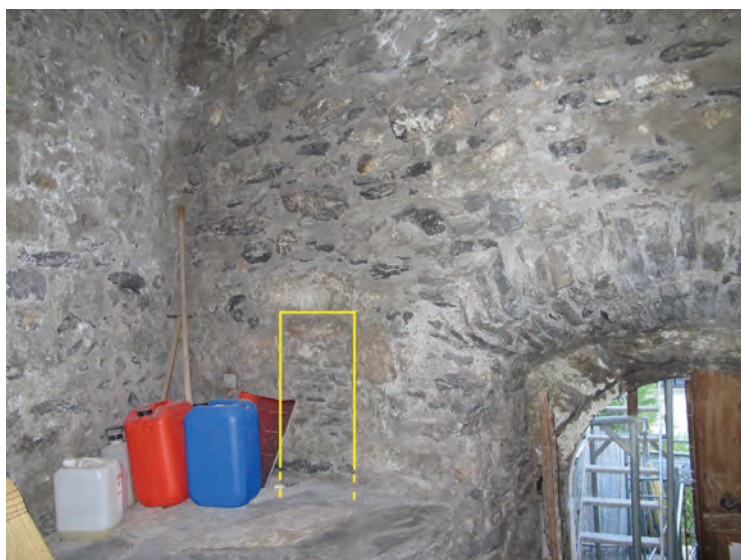
Fig. 6. Sion, Majorie. Tour-porche, intérieur vue vers l'est. Le cadre en tufs taillés de la meurtrière est visible derrière les bidons (en jaune).
