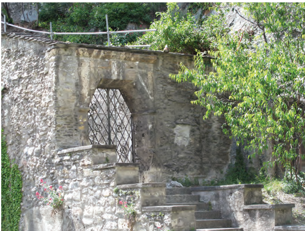
Fig. 12. Galerie d'accès orientale. Portail est, face extérieure.
