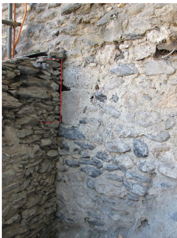
Fig. 5. Sion, Majorie. Galerie d'accès orientale, jonction entre le mur nord et la tour-porche, vue vers le sud. Le mur de la galerie recouvre le crépi de la tour et obstrue le jour d'une meurtrière (indiqué en rouge).
