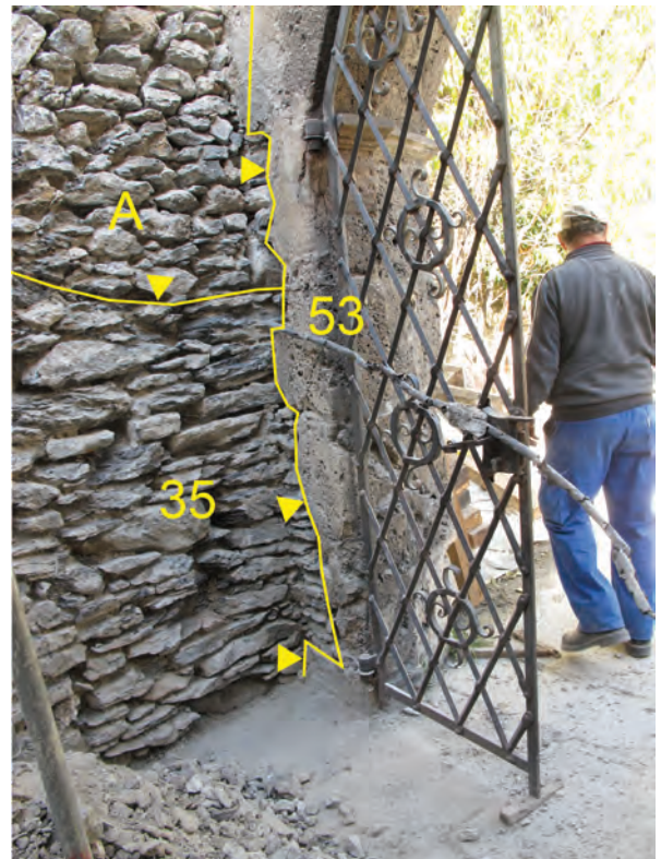
Fig. 11A. Sion, Majorie. Galerie d'accès orientale. Angle du mur nord (35) et du portail oriental. Le mur de la galerie (35) est probablement postérieur au piédroit du portail (53). Toutes les maçonneries s'appuient contre le cadre. A : remontage moderne.
