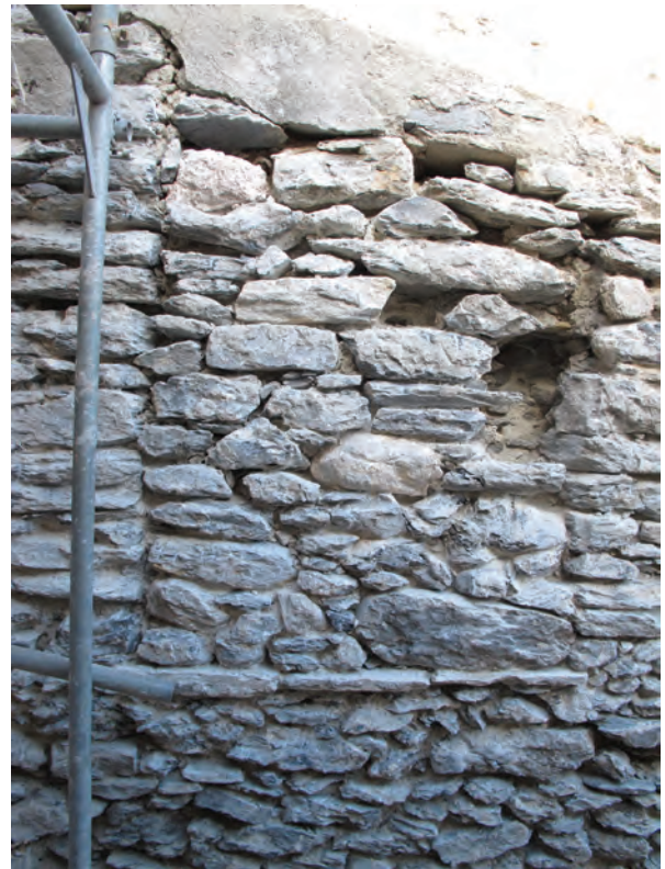
Fig. 15. Sion, Majorie. Galerie d'accès orientale, mur nord. Porte (43) prévue d'origine dans le mur. Du côté de la galerie, le seuil est constitué d'une marche d'escalier (A) et d'une dalle posée dans le prolongement de la marche (B). La maçonnerie du bouchon de la porte est soignée et liée au mortier à la chaux.
