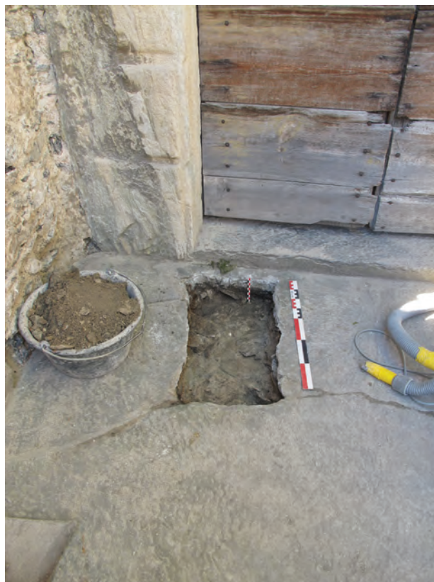
Fig. 7. Sion, Majorie. Galerie d'accès orientale, sondage dans le palier supérieur. 10cm sous le dallage actuel, une maçonnerie horizontale est apparue : le soubassement d'un escalier antérieur ?
