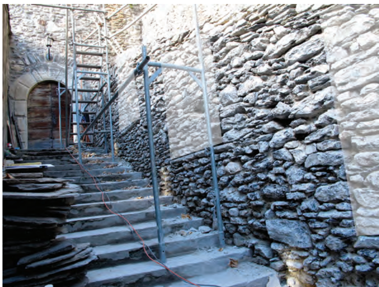
Fig. 4. Sion, Majorie. Galerie d'accès orientale, paroi nord. Les niches bouchées (trame blanche). Vue vers le nord-ouest.
