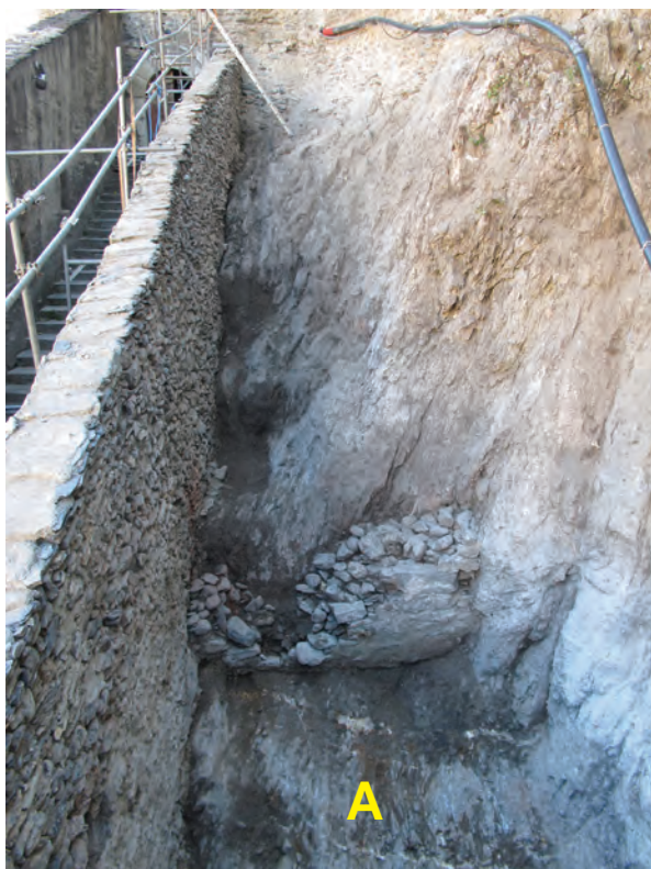
Fig. 17A. Sion, Majorie. Galerie d'accès orientale, espace résiduel entre le mur nord et le rocher, vu vers l'ouest. La face nord du mur est crépi à la hauteur du petit bâtiment (A) ; au-delà, le parement est moins soigné.
