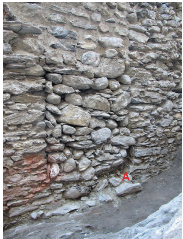
Fig. 15. Sion, Majorie. Galerie d'accès orientale, mur nord. Porte (43) prévue d'origine dans le mur. Du côté de la galerie, le seuil est constitué d'une marche d'escalier (A) et d'une dalle posée dans le prolongement de la marche (B). La maçonnerie du bouchon de la porte est soignée et liée au mortier à la chaux.
