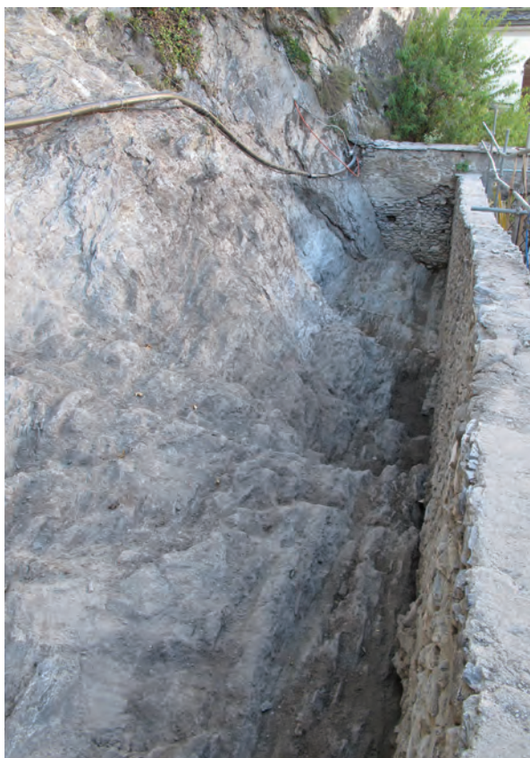
Fig. 8A. Sion, rue de Savièse 26, hall, vue vers le sud. Espace au nord de la galerie d'accès orientale, après la mise au jour du rocher. Vue vers l'est.
