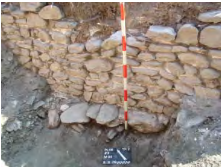
Fig. 12. Zone 3. Horizon R2. Détail de la maçonnerie et du ressaut de fondation du mur ouest du bâtiment 3 (M30). Profil est de la tranchée 2.
