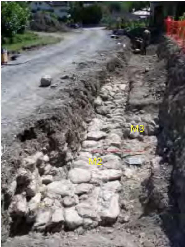
Fig. 13. Vue générale de la zone 4 (tranchée 2) en direction de la rue de Platta. Au premier plan, la fondation (M2) du mur occidental du bâtiment 2, avec le retour du mur nord. A droite, un autre mur (M3) de l'horizon R2 vient s'appuyer contre la fondation du bâtiment.
