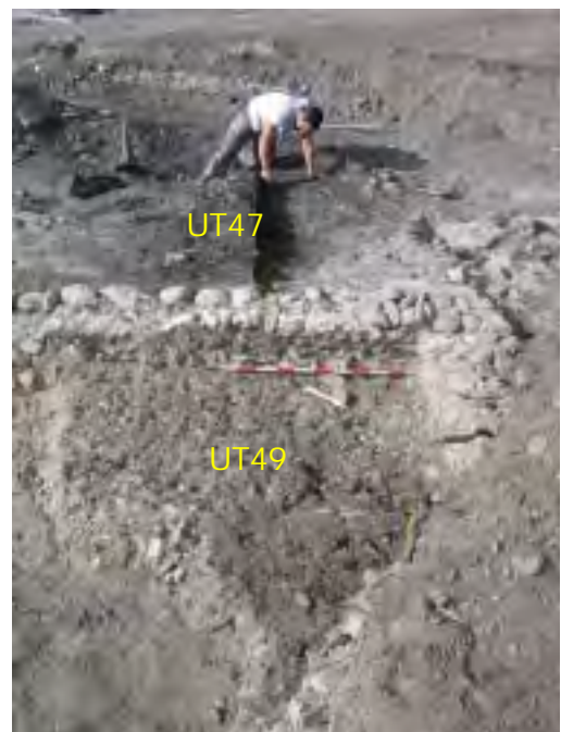
Fig. 19. Zone 5. Le bâtiment 5 (horizon R2) vu depuis l'est. La fosse extérieure (UT47) est en cour de dégagement alors que le sol en mortier (UT49) a déjà été fouillé.
