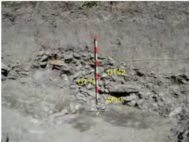
Fig. 8. Profil nord de la tranchée 1 en zone 2. Détail du mur de terrasse M10 (horizon R2), avec son drainage arrière constitué par un cailloutis (UT11). Plus tard, le mur a été recouvert par un simple talus de caillasses (UT42).
