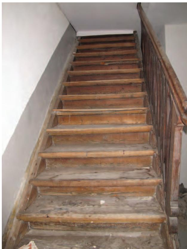
**Fig. 32A et B.** Sion, maison Brunner, corps principal, escalier sud (entre le 1<sup>er</sup> et le 2<sup>e</sup> étage), avec détail de sa balustrade. L'escalier en bois, à une seule volée, a été condamné après la construction de l'escalier nord-est en 1928.
