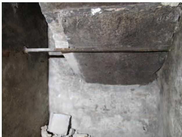
**Fig. 31.** Sion, maison Brunner, corps principal : sous l'escalier menant au 1<sup>er</sup> étage (local 1.3, vue vers le sud). L'escalier est installé sur des dalles inclinées soutenues par des barres de fer fichées dans les parois latérales.
