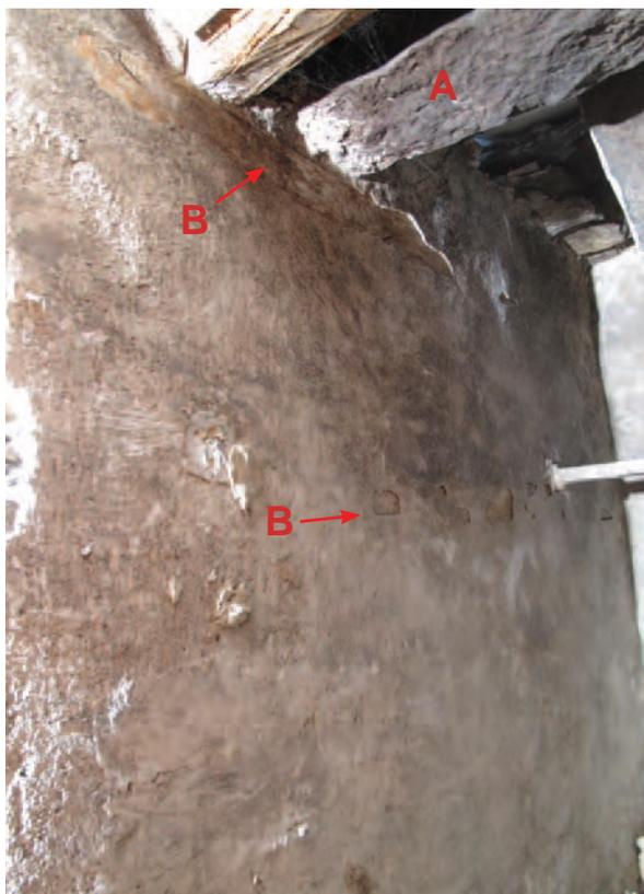
**Fig. 30.** Sion, maison Brunner, corps principal : cloison du couloir (local 1.3, mur est). Dans ce galandage renforcé par des poutres horizontales (B) est ancré l'escalier (A) menant au 1<sup>er</sup> étage.
