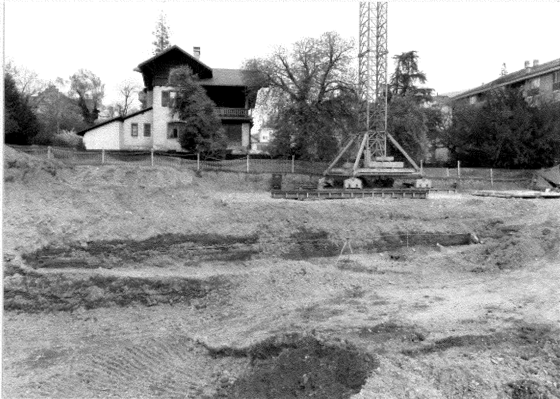
Etat des lieux au printemps 1988: séquence de limons dans la coupe de terrain sous la grue.
