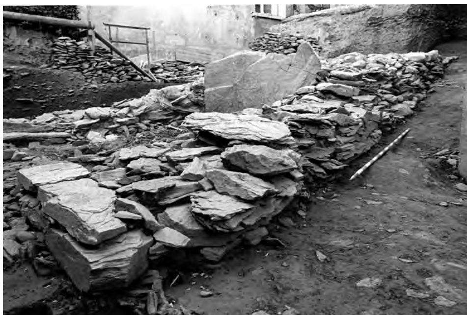
Fig. 19. Parement est du soubassement.
