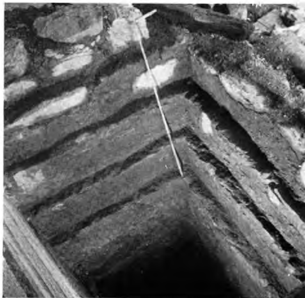
Tafel 31 B. Filzbach GL, Voremwald. Nordostecke des Turmes mit Fundamentvorsprüngen im Innern (S. 151).
