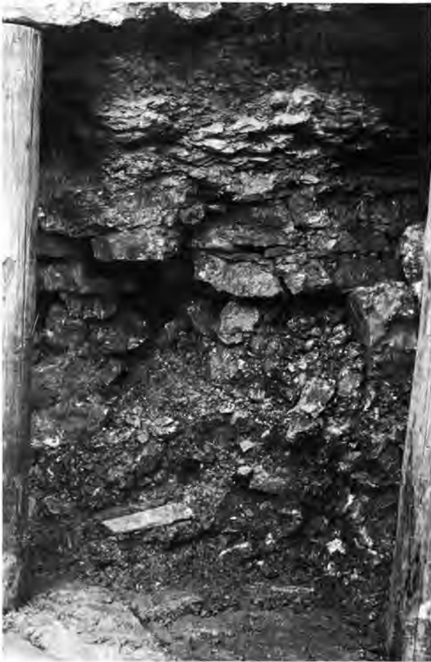
Abb. 11. Pleigne JU, Löwenburg. Zentralplatz, Ausweitung West: Teil des Untertagebaus («Weitung») mit der heutigen Sicherung durch Holzstempel. Der Bergbauschutt in der unteren Hälfte gibt die Höhe des alten Abbaus an.
