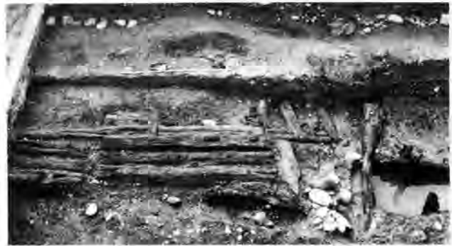
Abb. 59. Winterthur, Oberwinterthur ZH, Unteres Bühl. Mit Kies überschüttete Holzabdeckung des grossen Abwasserkanals. 2. Bauperiode.
