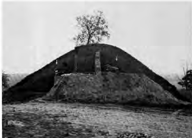
Fig. 44. Gressy VD, Butte de Sermuz. Coupe en travers du rempart, vue du Nord, avec, en profil, les deux parements, interne (à droite) et externe (à gauche).
