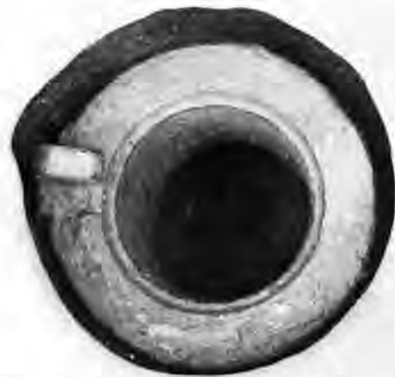
Fig. 55. Martigny VS. Thermes du téménos. L'embouchure en plomb de l'écoulement du bassin froid S. Diamètre extérieur 9,5 cm.
