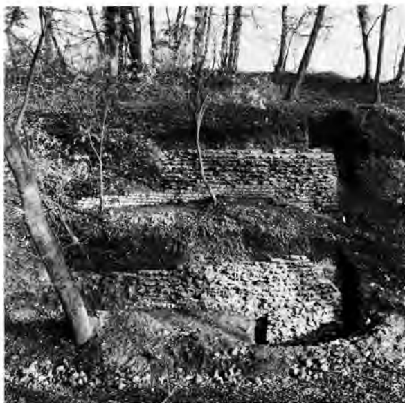
Abb. 37. Augst BL, Sichel. Amphitheater. Die Nordflanke des Ostzuganges mit dem Korridor zu den Zuschauerrängen an der Nordhälfte. Ansicht von Süden.
