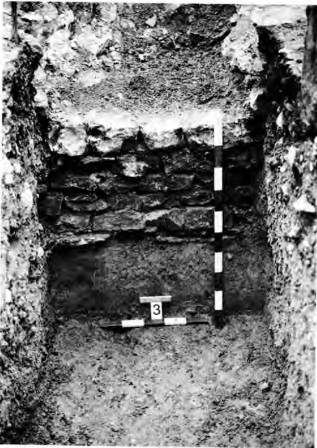
Abb. 37. Augst BL, Theater. Das Fundament der Orchestramauer (Abb. 35, B u. 36, M) mit regelmässigen Handquadern und zuunterst einer dünnen Lage von Kalksteinplatten (Abb. 36, A). Unter dem Mauerfundament der gewachsene Boden. Masseinteilung: 10 cm. Foto G. Sandoz.
