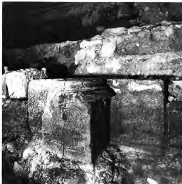
Abb. 20. Bern BE, ehem. Dominikanerkloster. Sockel und Basis des mittleren Wanddienstes im Kapitelsaal. Letztes Drittel 13. Jh. Photo: ADB, D. Gutscher.
