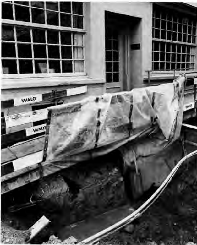
Abb. 34. Zürich ZH, Spiegelgasse 12. Frühmittelalterliches Grab bei der Freilegung.
