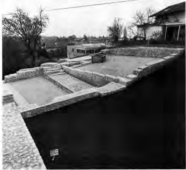
Abb. 24. Studen BE, Grabefeld Petinesca . Sanierung der römischen Anlage (Stand Herbst 1995).
