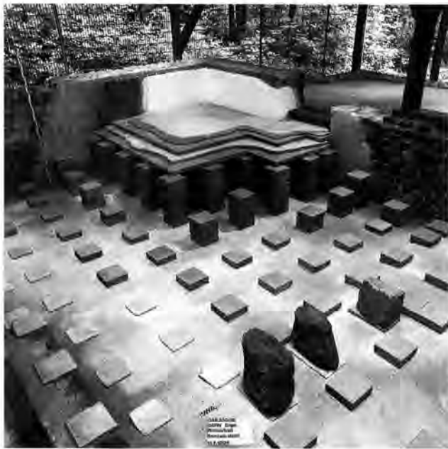
Abb. 12. Bern-Engehalbinsel BE, Reichenbachwald Römerbad. Im Massstab 1:1 rekonstruierte Hypokaustanlage im Bereich des Tepidariums.
