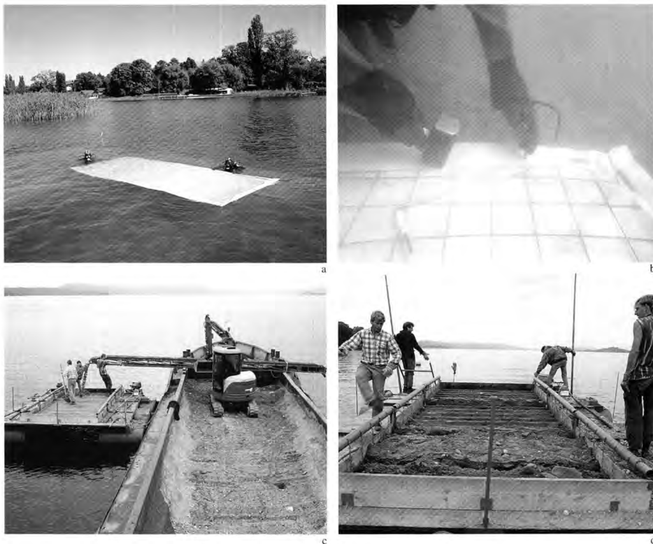
Abb. 2. Sutz-Lattrigen BE, Lattrigen Hauptstation-aussen. Schutzmassnahmen: a das mit Eisengitter verstärkte Geotextil wird gewässert und b auf dem Seegrund fixiert; c das Kies wird gleichmässig auf das Spezialponton verladen und d anschliessend über dem Geotextil eingebracht. Photos ADB.
