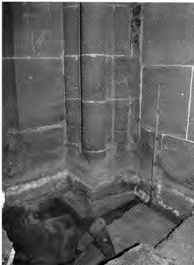
Fig. 49. Fribourg FR, cathédrale St-Nicolas. Cinquième travée, bas-côté sud, base dégagée du pilier d'angle et ancien dallage de molasse. Photo SAEF, G. Bourgarel.
