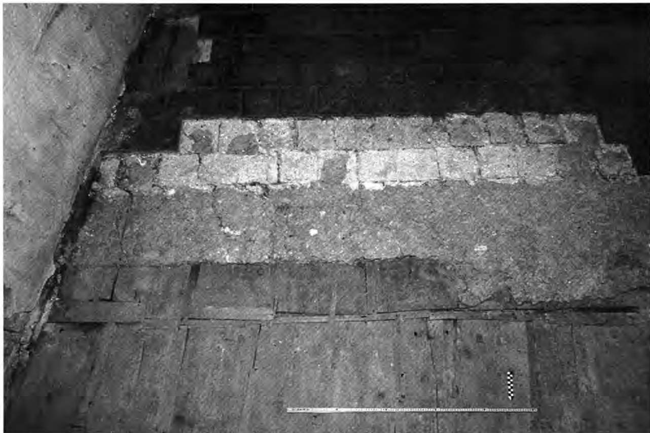
Fig. 48. Fribourg FR, Abbaye de la Maigrange. Premier étage de l'ancienne abbatale, détail du sol de 1431. Photo SAEF, P. Cogné.
