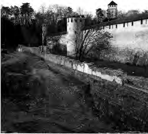
Abb. 39. Basel BS, St. Alban-Rheinweg 118–126 (Mühlegraben). Blick nach Süden über Baugrube, Kontermauer, Stadtgraben und Stadtmauer (im Hintergrund das St. Alban-Tor). Auf den Fundamenten der Kontermauer stand bis 2005 ein Fabrikgebäude (verputzte Stellen). Foto Ch. Matt.
