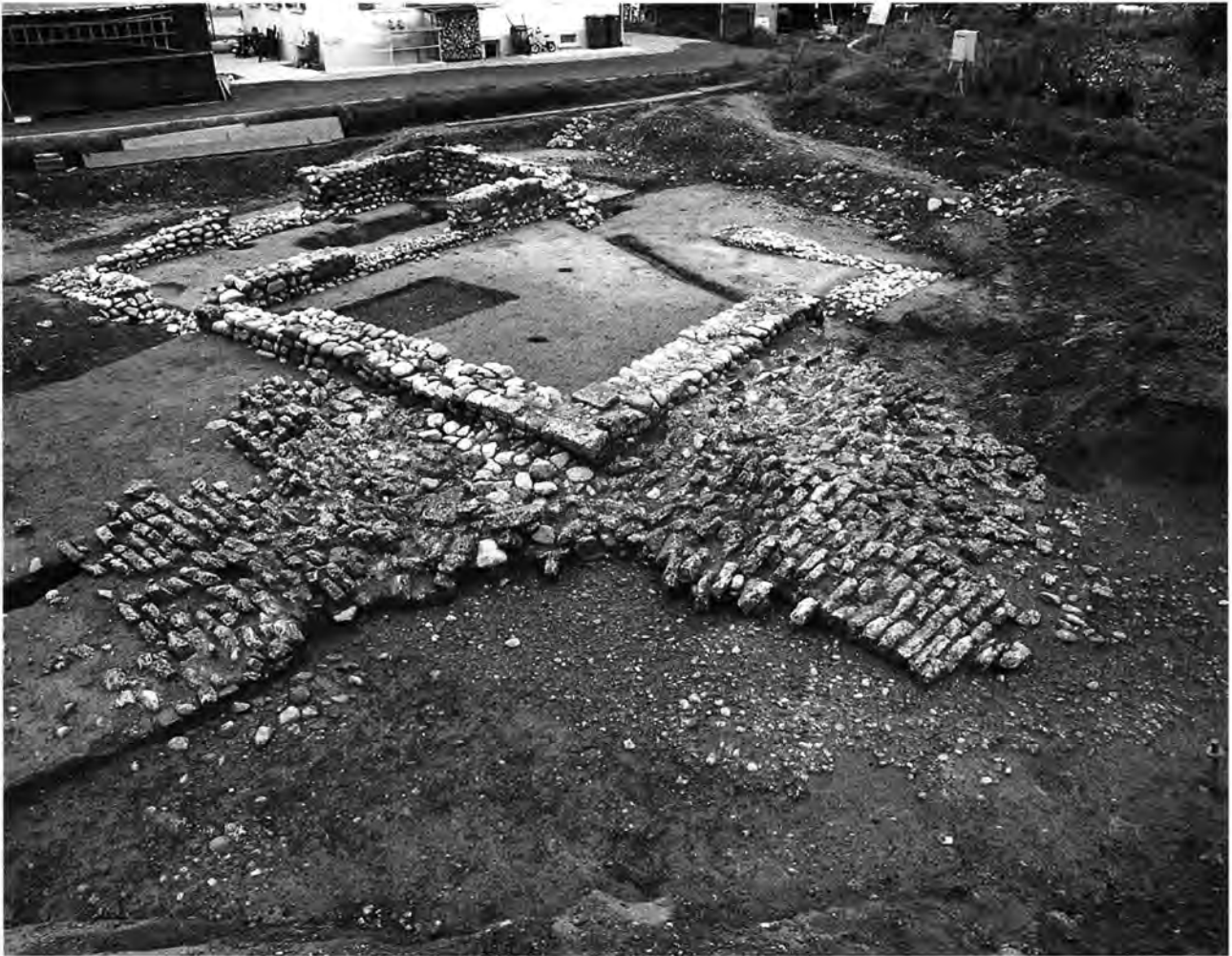
Abb. 36. Wetzikon-Kempton ZH, Kindergartenstrasse Kat.-Nr. 8309. Vom spektakulären Einsturz der Gebäuderuine zeugen Reste der nach aussen umgeköpften, mit Tuffsteinen verblendeten Wände. Foto KA ZH, Ch. Héglé.
