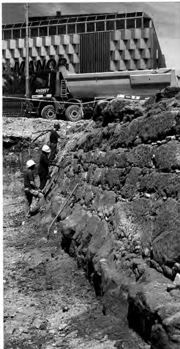
Fig. 52. Fribourg FR, Avenue de Tivoli-Grand-Places. Mur occidental de l'ouvrage à cornes en juin 2005. Photo SAEF, G. Bourgarel.
