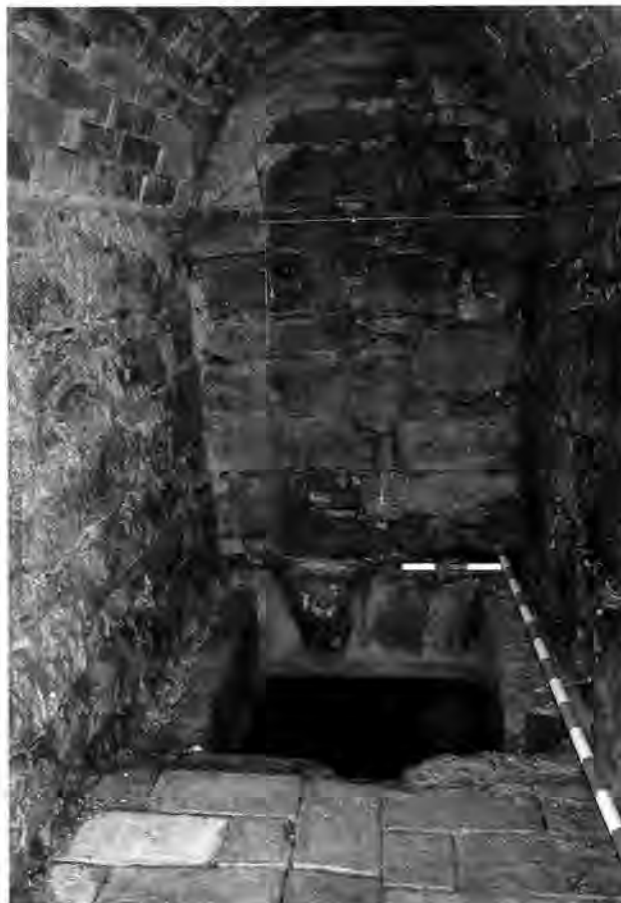
Abb. 53. Salenstein TG, Schloss Arenenberg, Gartenanlage. Fäkalienbecken mit Zuleitung aus dem Schloss. 1830er Jahre. Foto Amt für Archäologie TG.
