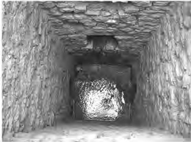
Abb. 20. Windisch AG «Im Winkel». Der Kontrollschacht der laufenden römischen Wasserleitung. Foto KA AG.
