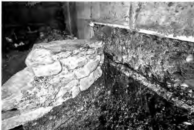
Abb. 37. Basel BS, Petersgasse 36. Mit gelbem Schwenmlehm «vermörteltes» Steinfundament eines (Fachwerk?) Hauses. An seiner Aussenseite entsprechend auf das Gelniveau verstärkter Brandschutt und darunter ein Lehmestrich. Foto ABB5.
