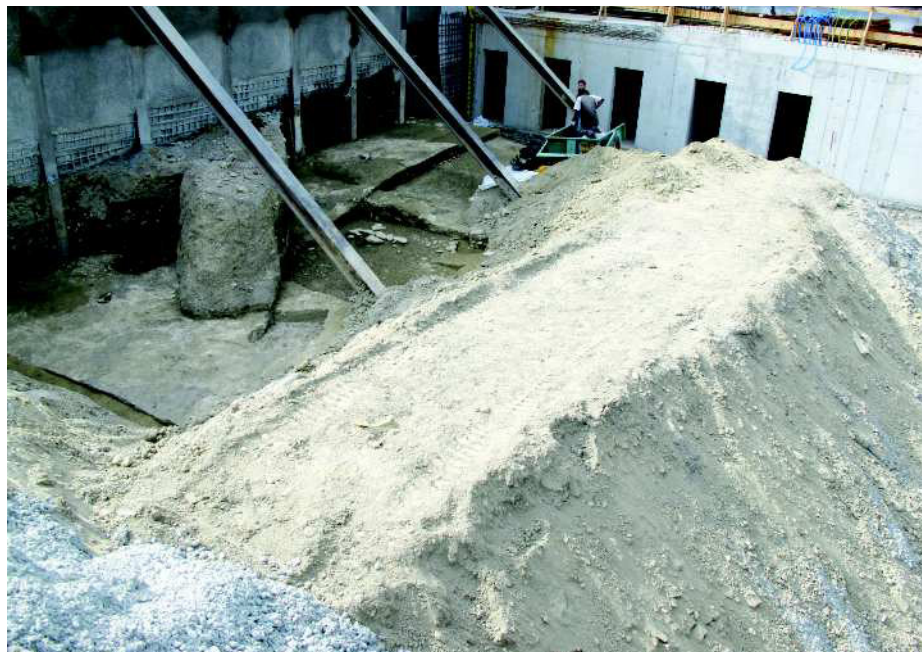
Vue générale du chantier, depuis le sud
