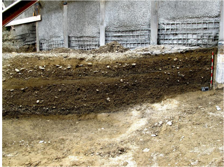
Fig. 4 : Sierre, Le Plan de Noës. stg 24, profil ouest du chantier. Plusieurs couches du cône torrentiel sont visibles. Vue du nord.
