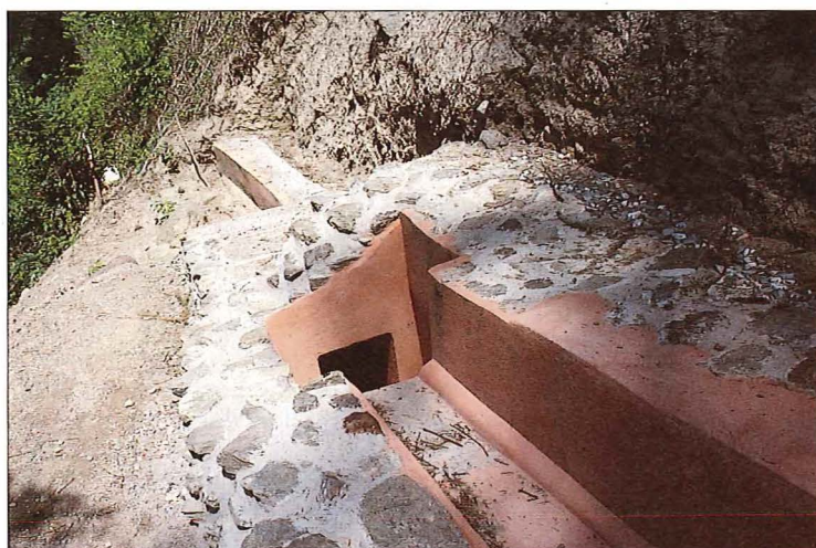
Fig. 22 — Martigny , au pied du Mont-Chemin, aqueduc. Tronçon de l'aqueduc avec une chute, restauré dans le cadre du «Parcours Vita».
