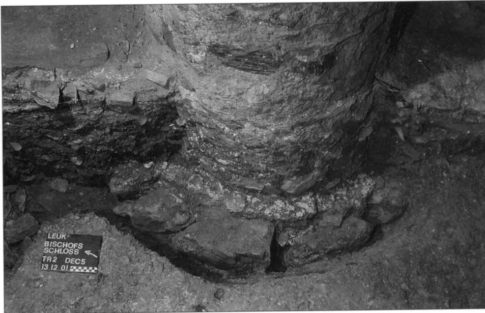
Fig. 10 – Leuk, Bischofsschloss/Château épiscopal Palas. Kellergeschoss, Détail des Pfeilerfundamentes.
