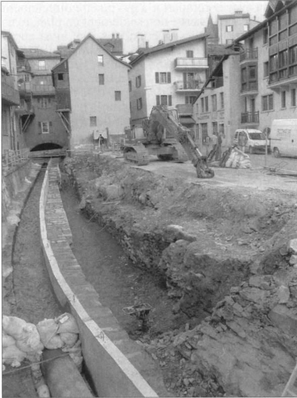
Fig. 20 – Sion, Place des Tanneries: Apparition des caves de l'ancien quartier des Tanneries après démontage du mur de digue de la Sionne. Vue depuis le sud-est.
