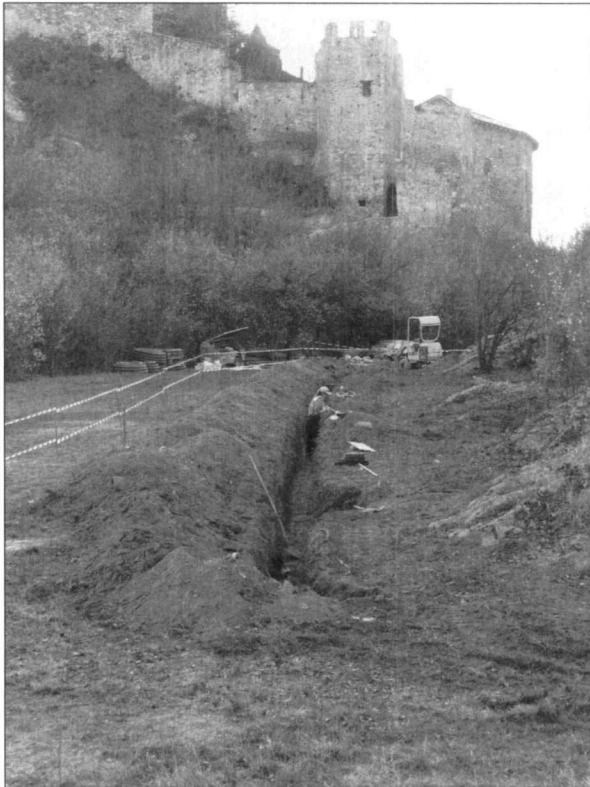
Fig. 16 – Sion, Valère «En Prélet». Tranchée principale creusée sur le replat. En arrière plan, le château. Vue depuis l'est.
