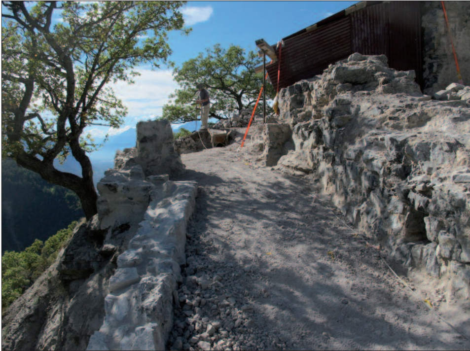
Fig. 5 – Chippis, Château de Beauregard. La rampe longeant le logis après la consolidation de la courtine sud. A droite de l'arbre, les deux montants de la porte qui délimitait la cour supérieure. Vue vers l'ouest, septembre 2010.
