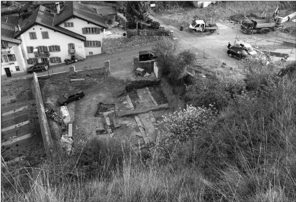
Fig. 29 – Sion, Parking de l'Ancien Pénitencier, fouilles 2010. Vue générale du site depuis la colline de Valère. Au centre, le couloir du corps de bâtiment barrant le vallon entre les collines de Valère et Tourbillon.
