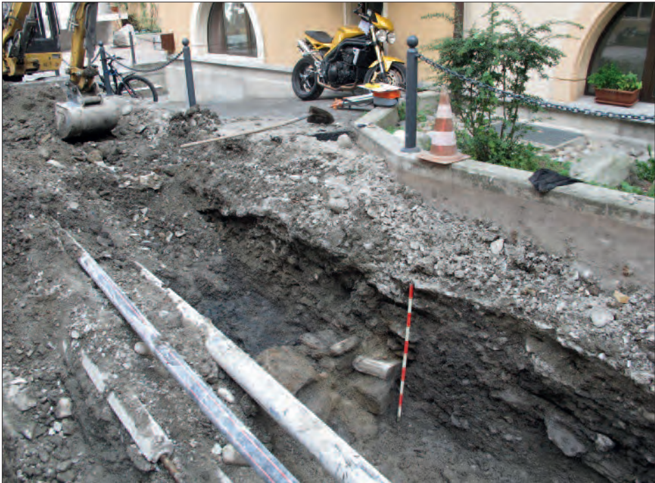
Fig. 16. Sion, ruelle de la Lombardie. Mur nord d'un édifice semi-enterré qui pourrait être antérieur à la ruelle. Vue depuis le nord. (Photo: TERA, Sion)
