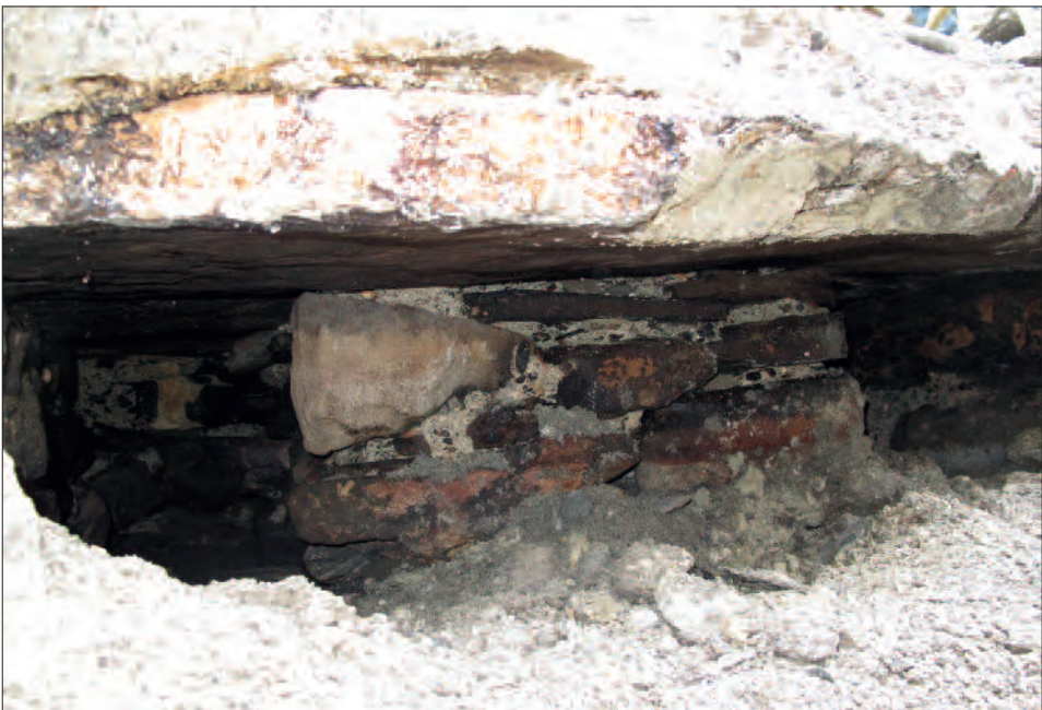
Fig. 20. Saint-Maurice, avenue d'Agaune. Socle maçonné soutenant le dernier sol de l'aula. Vue depuis l'est dans la tranchée gaz en 2012.
