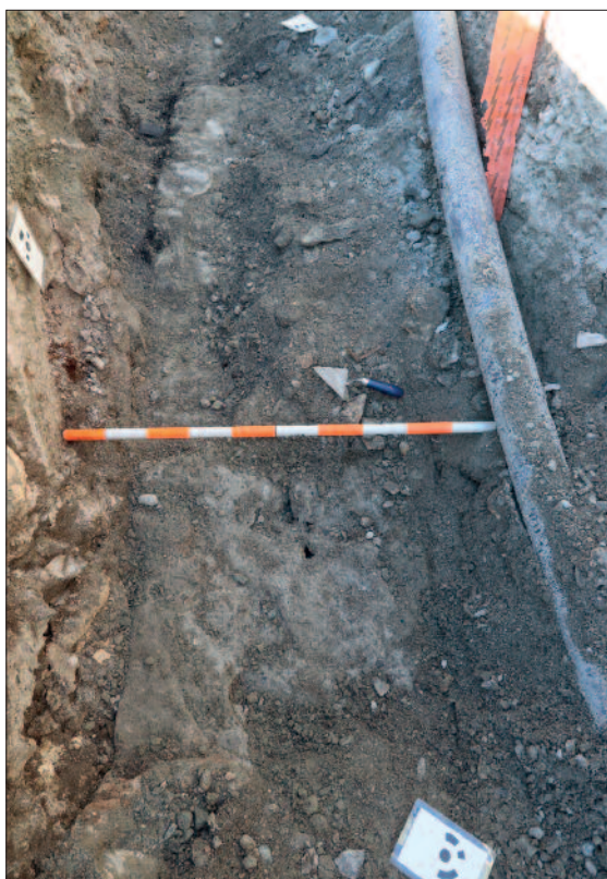
Fig. 27. Sierre, rue Sainte-Catherine. Fondations de la façade sur rue de l'un des bâtiments pouvant correspondre aux communs du château de Villa. (Photo: © SBMA)
