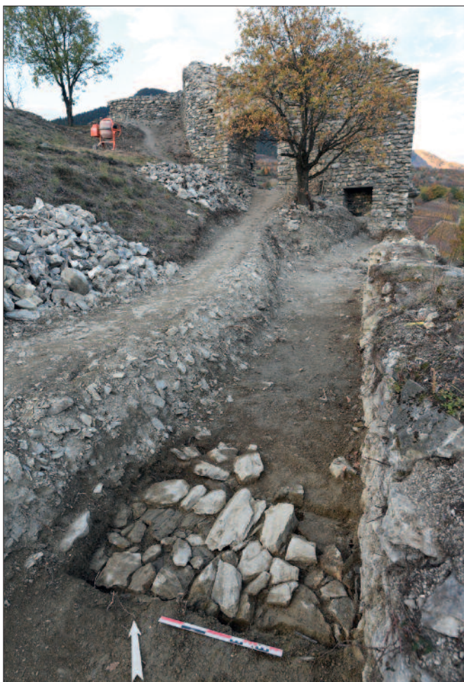
Fig. 25. Savièse, château de la Soie. Vue du mur bouclier avec, au premier plan, une des structures mises au jour à l'arrière de la courtine sud. (Photo: © TERA)
