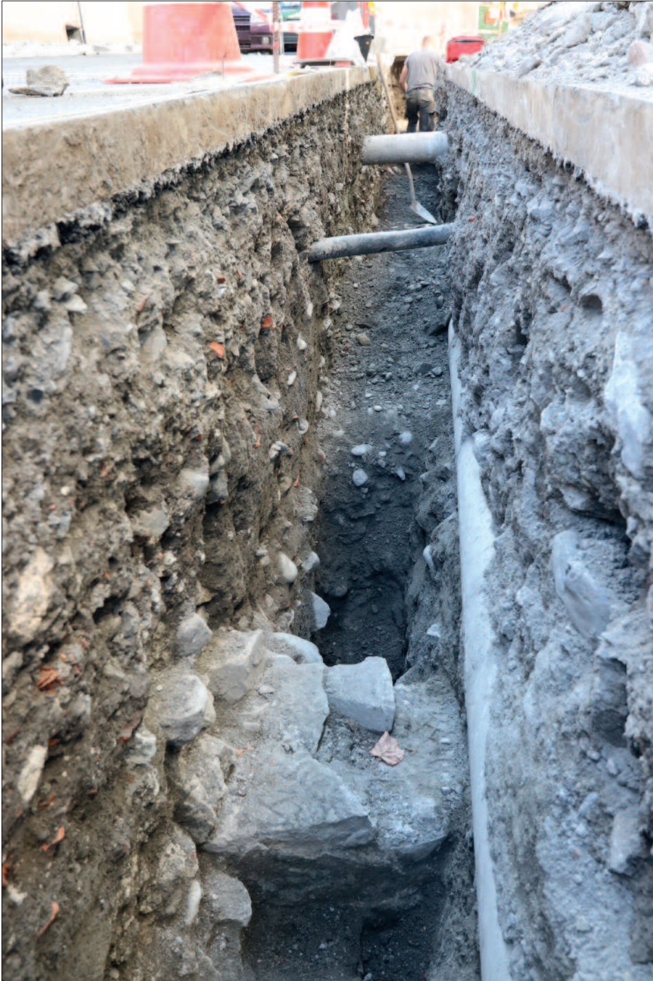
Fig. 22. Massongex, maison de commune. Tranchée sud-ouest. En bas, le mur sud bordant les niveaux de voirie.
