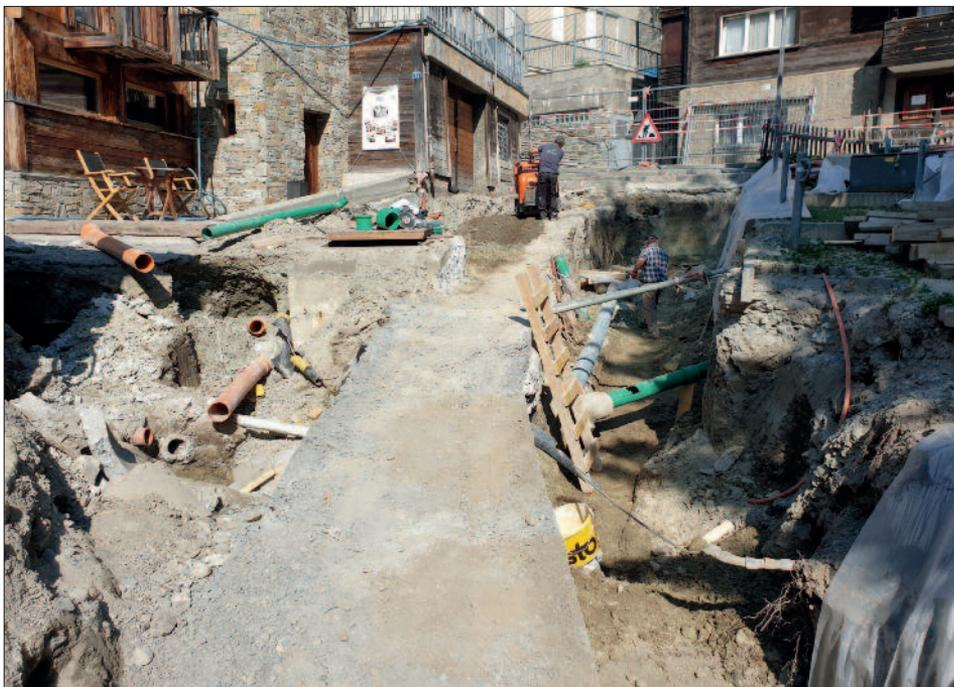
**Abb. 39. Zermatt, Chirchplatz.** Sanierung Werkleitungen Chirchplatz.
