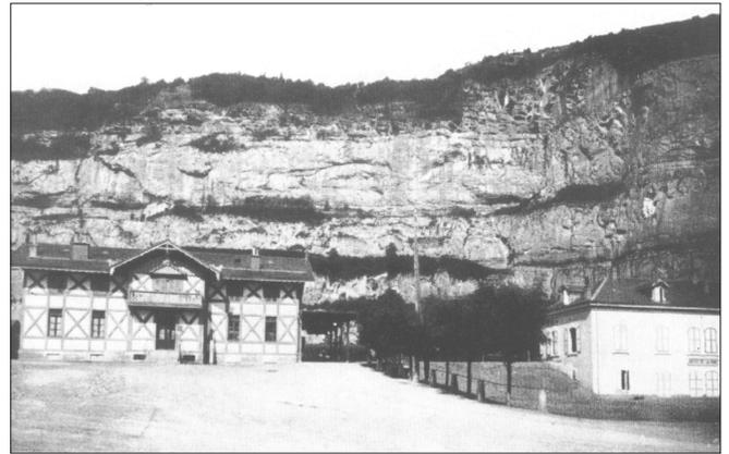
**Fig. 6** - St-Maurice, tranchées gare. L'ancienne gare en colombage est bâtie au bord des voies et au sommet d'une rampe artificielle qui compense la dénivellation entre le terre-plein des voies et les environs. A droite, le bâtiment du buffet de la gare, actuellement en cours de restauration. Image tirée de *Saint-Maurice – hier et avant-hier*, publié par l'Association du Vieux Saint-Maurice, 2001.
