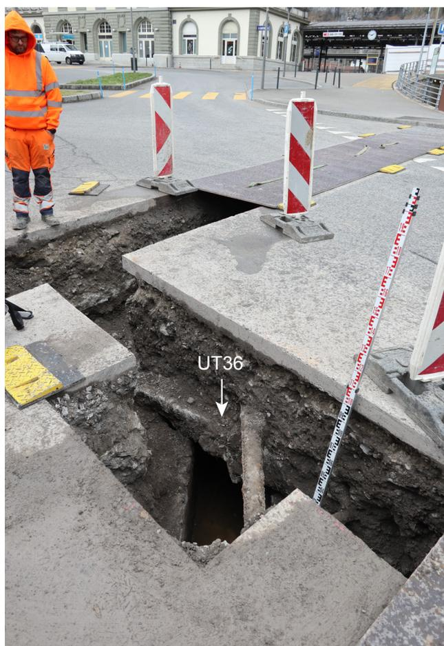
**Fig. 16** - St-Maurice, tranchées gare. La canalisation maçonnée UT36 est associée à l'annexe de la gare actuelle. Il est possible qu'elle ait été construite en même temps que l'ancienne gare en colombage (étape 7). Vue du nord-est.
