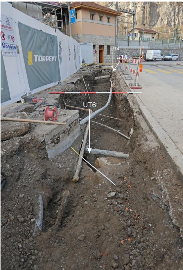
**Fig. 13** - St-Maurice, tranchées gare. Près du local technique, les maçonneries UT4 et UT5 sont apparues dans le profil sud-est de la tranchée. Elles sont interprétées comme des structures installées pour la construction du chemin de fer et/ou des bâtiments de la gare. Au premier plan, une canalisation maçonnée UT6 associée au bâtiment du buffet de la gare (tranchée étape 2). Vue du sud-ouest.
