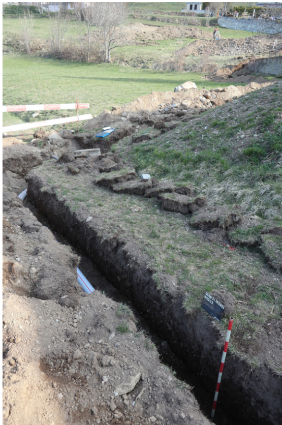
Abb.8 – Guttet-Feschel, Wiler. Anlage der Gräben zum Einzug der elektrischen Leitungen. Im Hintergrund hangaufwärts die Ausgrabung.
