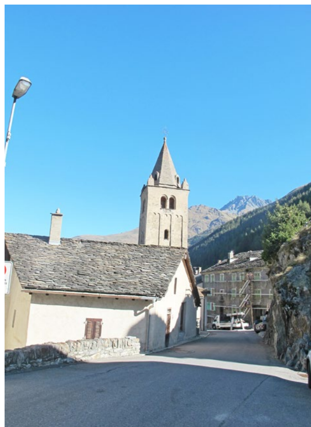
Fig. 30 – Bourg-St-Pierre, rue de l'Eglise. Au premier plan la maison du « Prieuré », vue du sud. La rue actuelle a été créée grâce à la démolition d'une maison autrefois construite contre le rocher à droite qui a vraisemblablement été taillé lui aussi pour la création de la rue.
