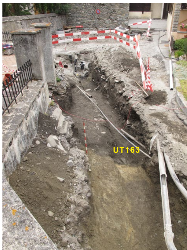
Fig. 15 – Bourg-St-Pierre, rue de l'Eglise. Tranchée sous la place devant la maison St-Pierre, vue depuis l'est. Les flèches désignent le bord oriental de l'excavation pratiquée dans les colluvions avant le terrassement pour le cimetière romane. Le long du bord de l'excavation se distinguent les quelques pierres de l'aménagement ( UT163 ) associé à l'excavation.
