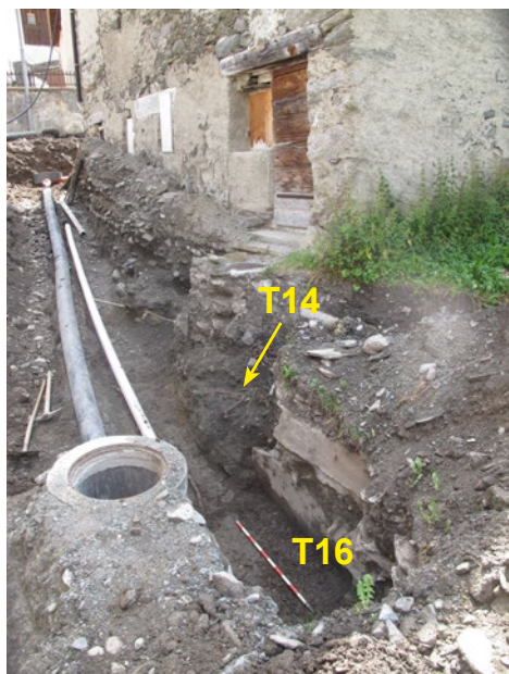
Fig. 19 – Bourg-St-Pierre, rue de l'Église. Tranchée dans la ruelle perpendiculaire à la rue, en face de l'église, vue du nord. La tombe en dalles T16 et la tombe en pleine terre T14 ont été analysées au radiocarbone.
