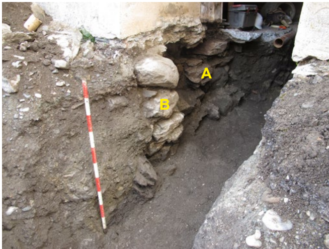
Fig. 23 – Bourg-St-Pierre, rue de l'Eglise. Entrée de la cave du «Prieuré», vue de l'ouest. A : base de la façade ouest du bâtiment, percé par la tranchée. B : base de la maçonnerie qui double cette façade en glacis.
