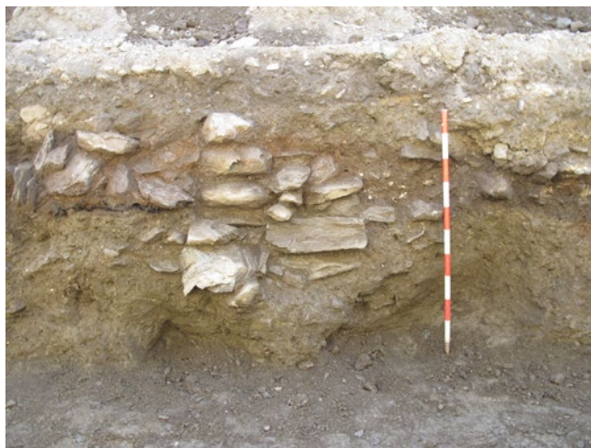
Fig. 5 – Bourg-St-Pierre, rue de l'Eglise. Tranchée effectuée à l'ouest de l'église, vue de l'ouest. Mur M93, d'orientation similaire à celle du grand axe des églises romane et baroque.
