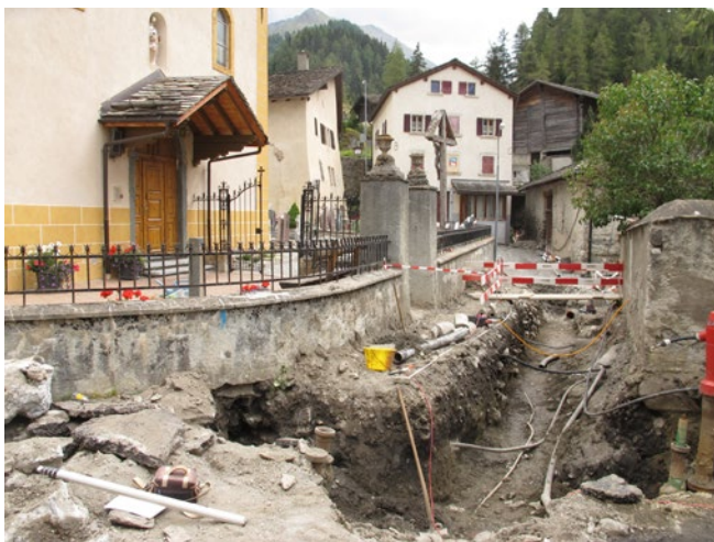
Fig. 7 – Bourg-St-Pierre, rue de l'Eglise. Vue du chantier depuis la place devant la maison St-Pierre, vue depuis le nord. La maison du «Prieuré» se dresse au sud de l'église. Sa façade ouest renforcée et ses petites fenêtres trahissent son ancienneté.
