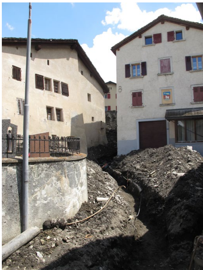
Fig. 1 – Bourg-St-Pierre, rue de l'Eglise. Premier tronçon de tranchée creusé au sud du cimetière actuel, vue du nord. La maison à gauche est habituellement appelée le «Prieuré».
