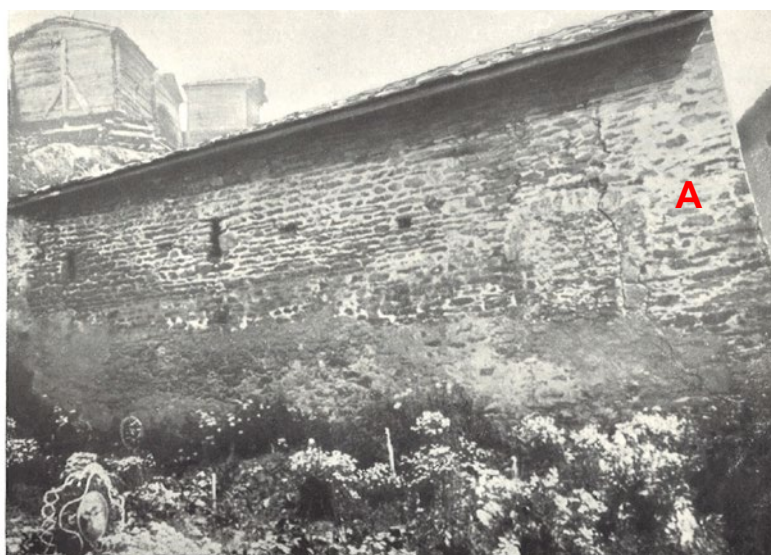
Fig. 22 – Bourg-St-Pierre, rue de l'Eglise. Façade nord du « Prieuré », dans les années 1940. A : chaînage nord-ouest du bâtiment qui suppose que la façade ouest a peut-être été entièrement reconstruite. Image tirée de L. Blondel, « L'église et le prieuré de Bourg-St-Pierre », Vallesia 1, 1946, Pl. I.
