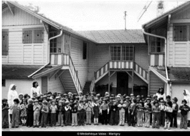
Mission catholique italienne, Naters, 1976. Photo Médiathèque Valais – Martigny ; René Rflier.
