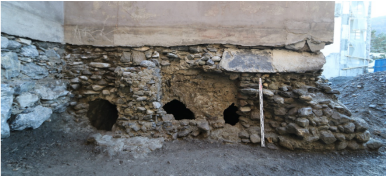
Ansicht der hinter einer Steinmauer entdeckten Grabgewölbe an der Aussenmauer des Gebäudes.
