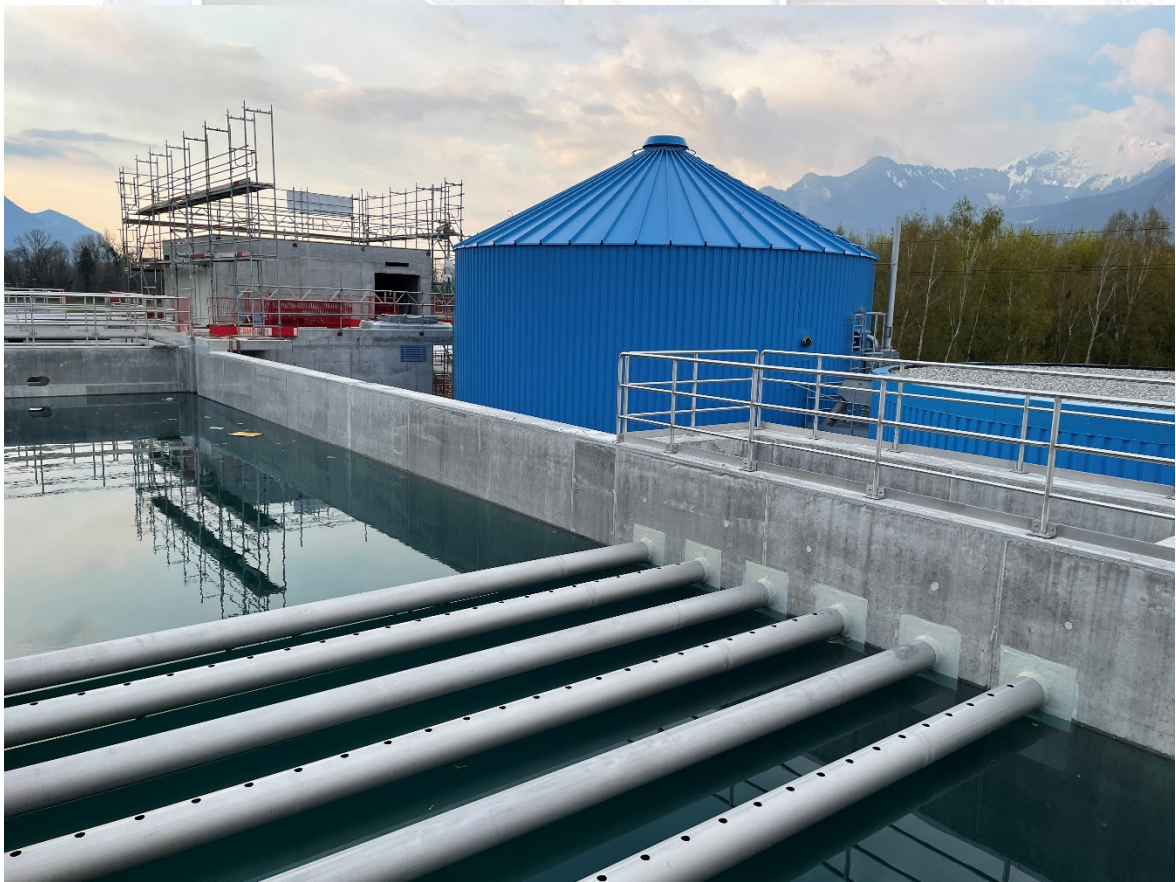
ARA Collombey-Muraz : Wassertest des Nachklärbeckens mit neuem Faulturm im Hintergrund
