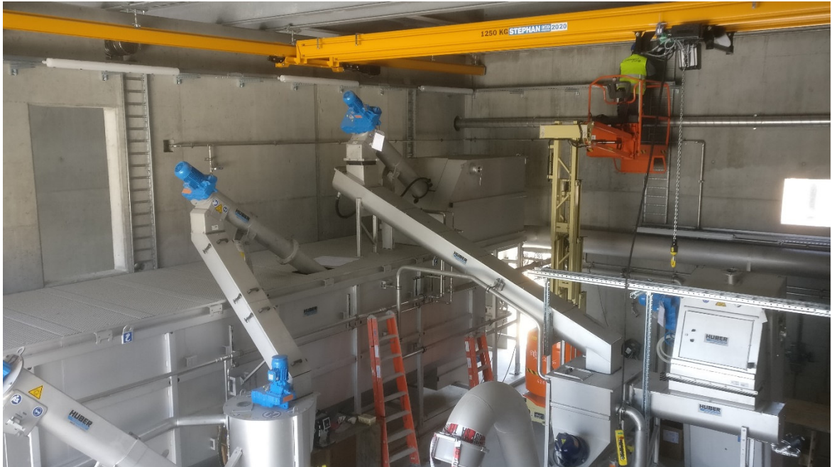
Abb. 11: ARA Collombey-Muraz – neues Vorbehandlungsgebäude
