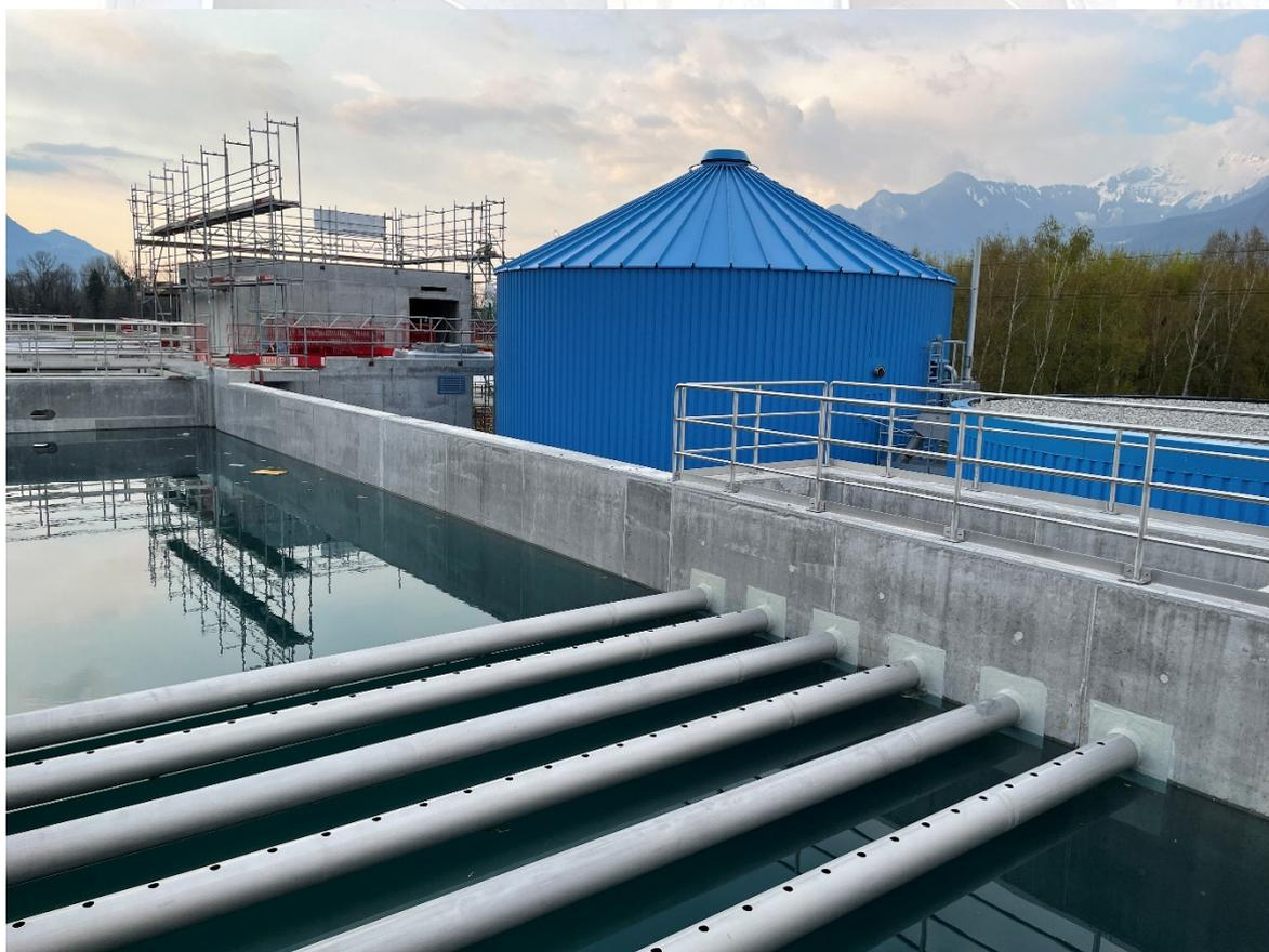
STEP de Collombey-Muraz : test en eau du décanteur secondaire avec nouveau digesteur en arrière-plan
