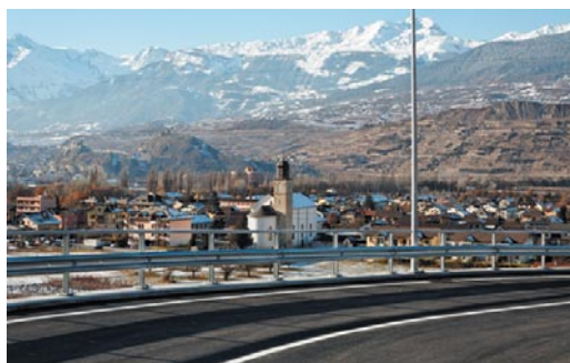
Umfahrung Bramois: Pro Tag fahren 2'500 Fahrzeuge weniger durchs Dorf.
