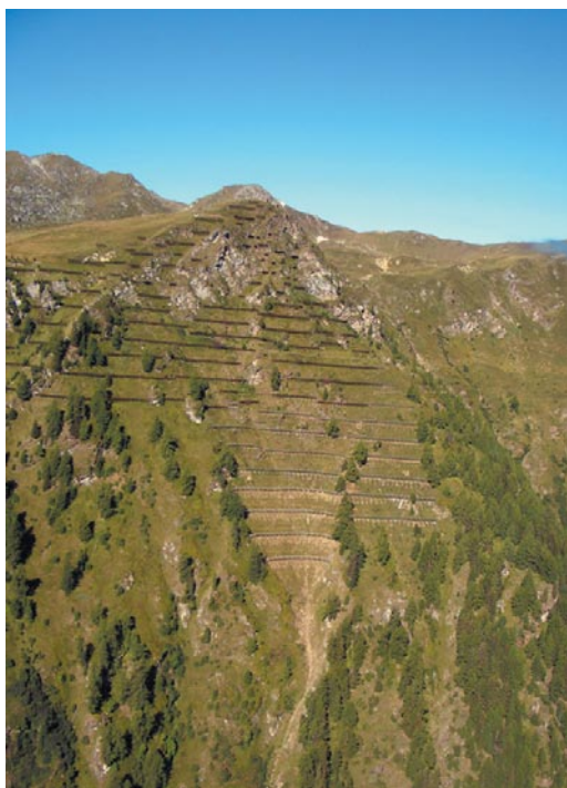
Lawinenverbauungen in Hérémence
