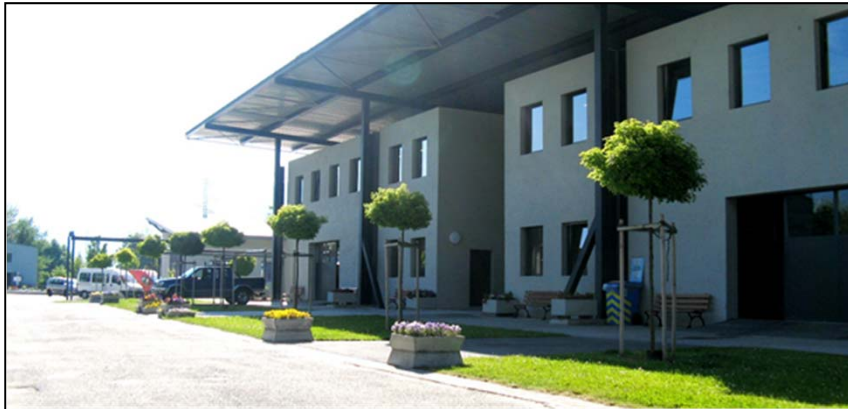
Centre de formation Valais central – « Le Botza »
