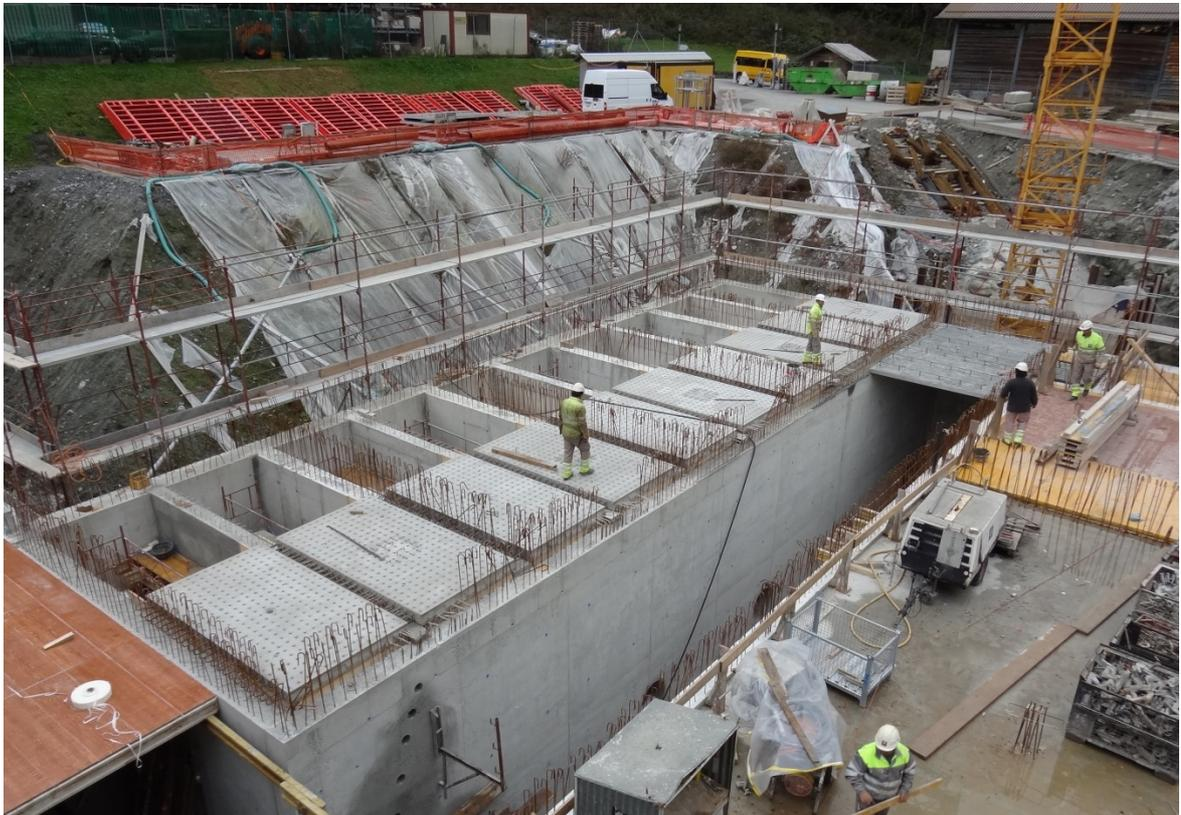
Figure 6 : STEP Bagnes-Le Châble – Pose du plafond des cellules Biostyr®
