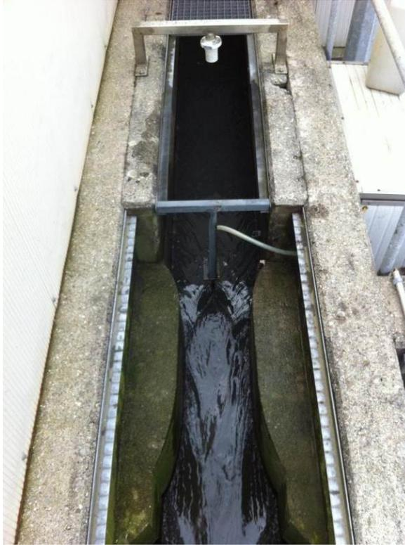
Figure 9 : Débitmètre Venturi entrée STEP Collombey-Muraz
