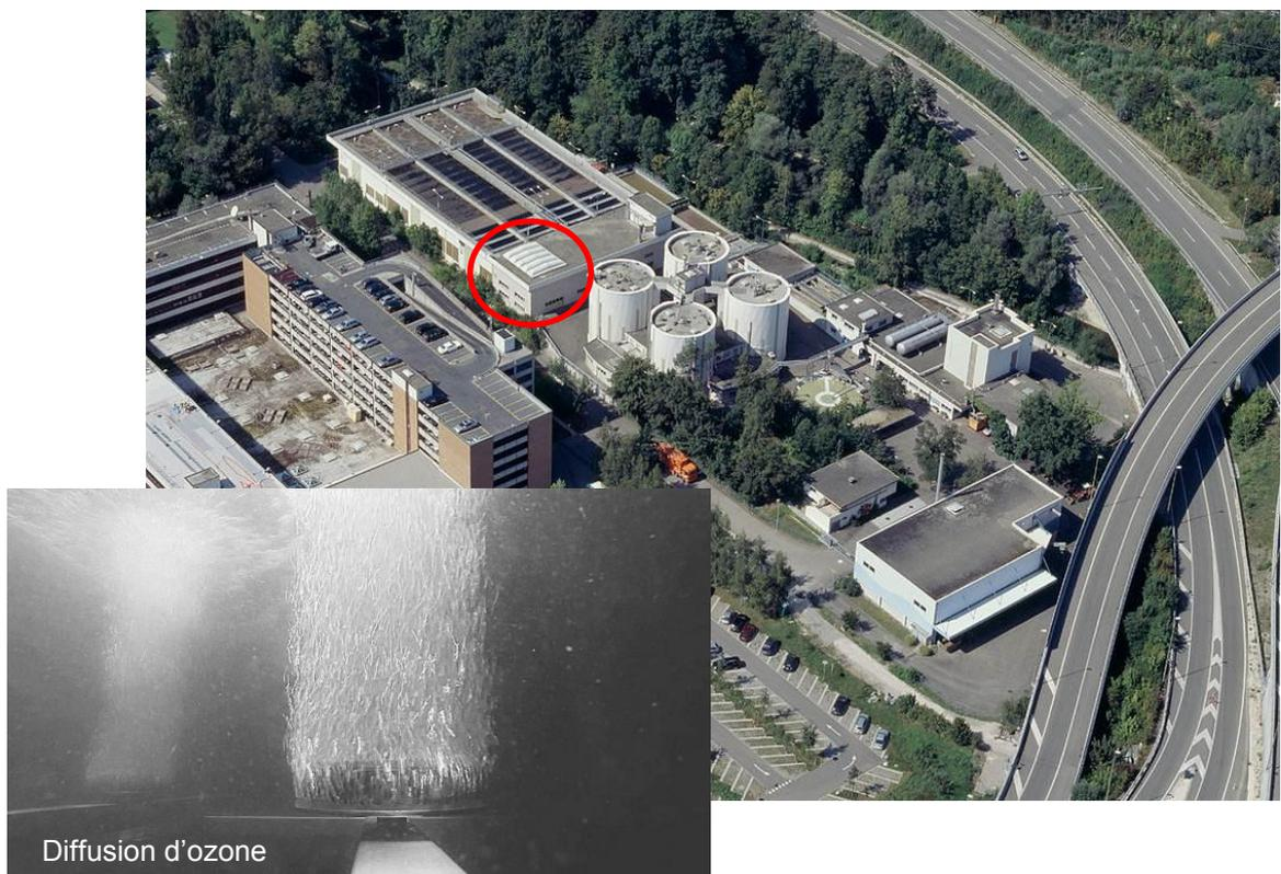
Figure 22 : STEP Neugut à Dübendorf (150'000 EH) : première STEP suisse équipée pour le traitement des micropolluants par ozonation (source : [www.neugut.ch](http://www.neugut.ch))
