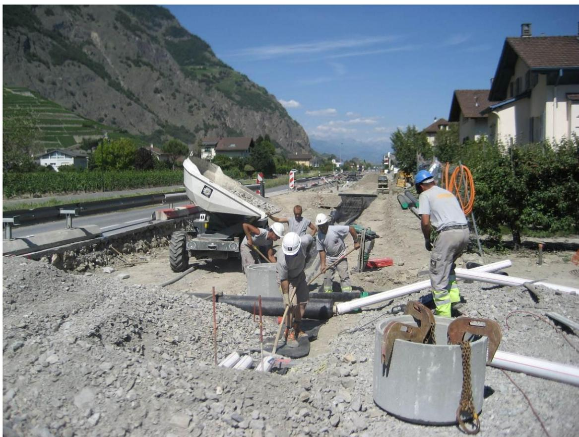
Figure 12 : Commune de Fully : pose du collecteur des eaux usées rive gauche
