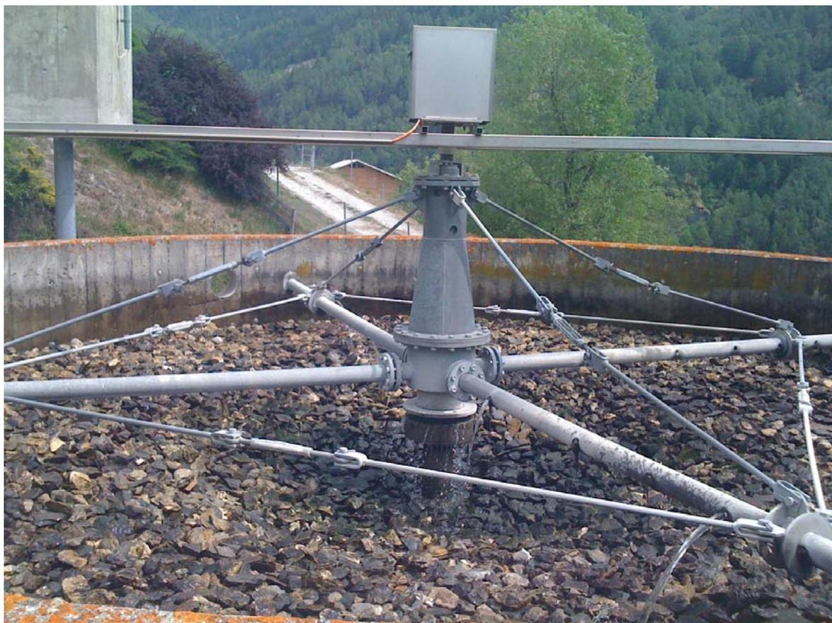
Figure 17 : STEP de Mase – colmatage du bras asperseur
