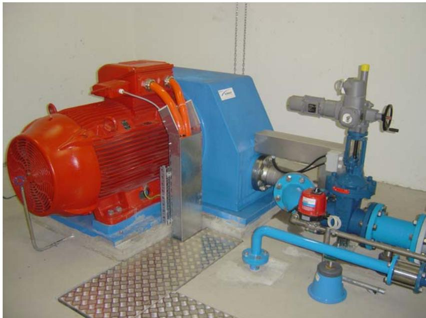
Figure 19 : STEP de Grächen – turbinage des eaux traitées (80 l/s)
