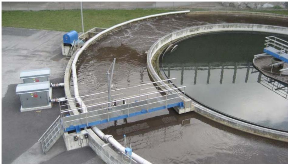
Figure 5 : Extension STEP d'Evionnaz et environs (9'000 EH, avec nitrification)
