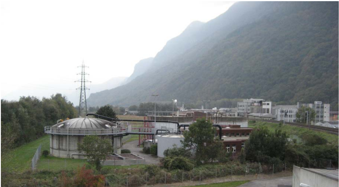
Abb. 22 : ARA der BASF Pharma (Evionnaz) SA
