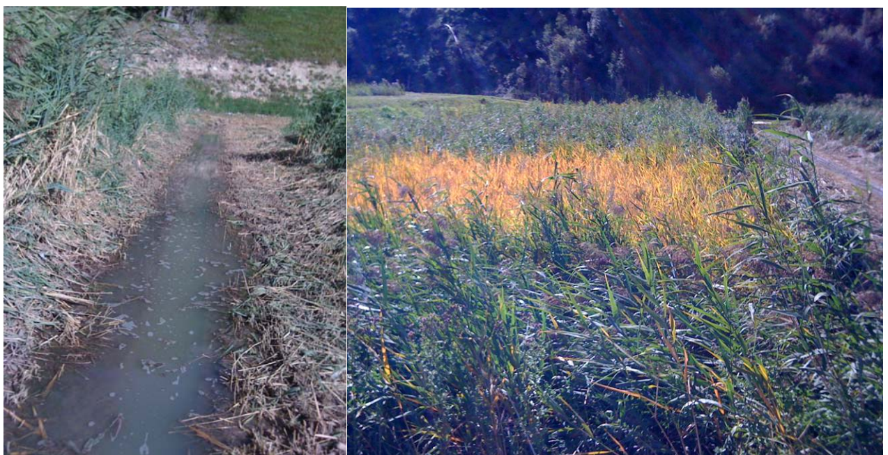
Abb. 11: ARA Wiler : Überfüllung und mangelndes Wachstum im Schilfrohrbeet
