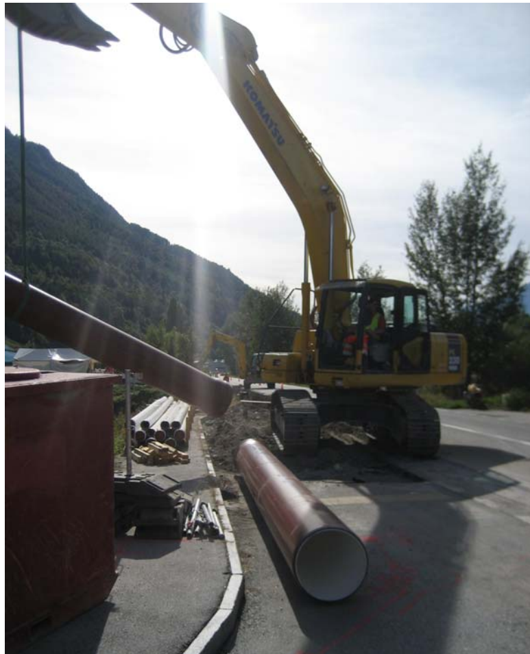
Abb. 9 : Aproz: Arbeiten am Abwassernetz
