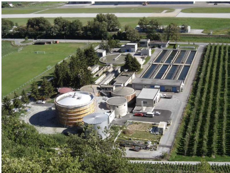
Foto 8: ARA bei Sion-Châteauneuf (Kapazität: 66'000 EGW, 2006).
