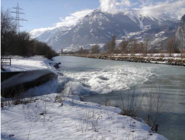
Restitution eaux de Grande Dixence au Rhône (2005)
