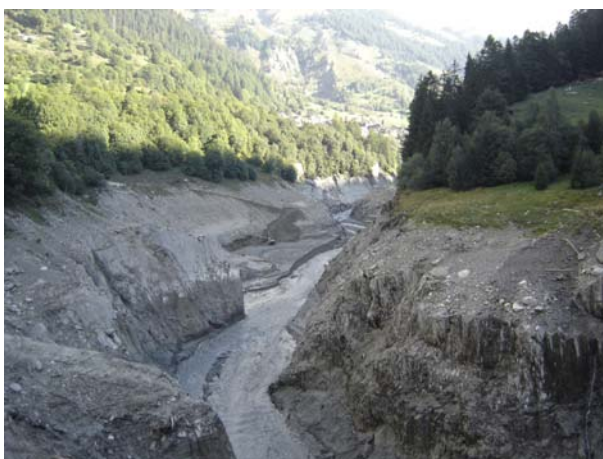
Vidange du barrage de Ferden (2005)
