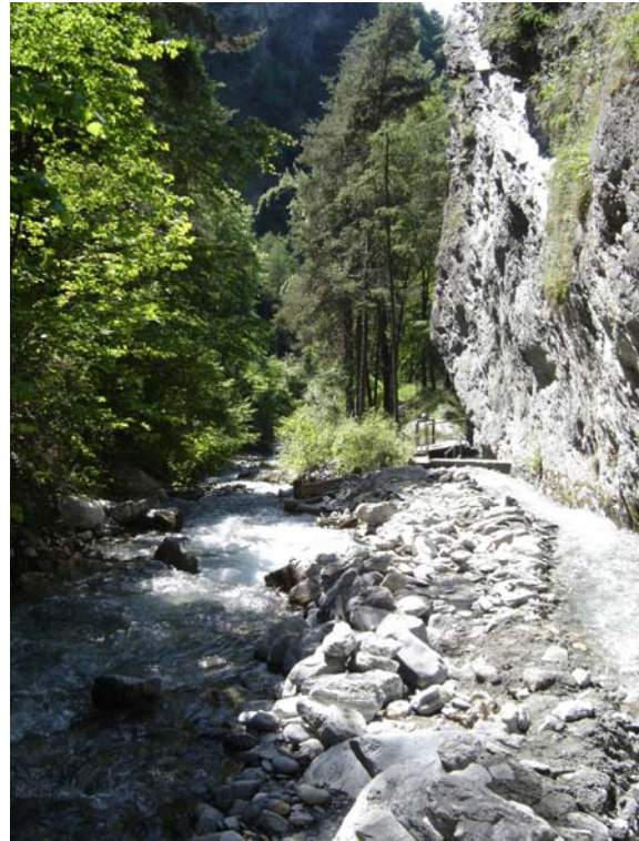
Fare en amont de Riddes captage du bisse (2006)
