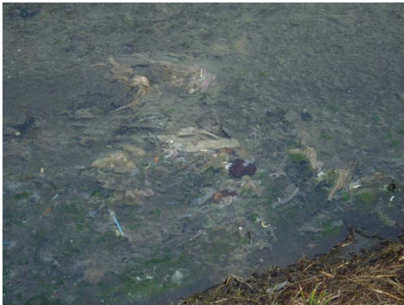
Foto 7: Abwasserabfälle in der Sohle eines Kanals (2006).
