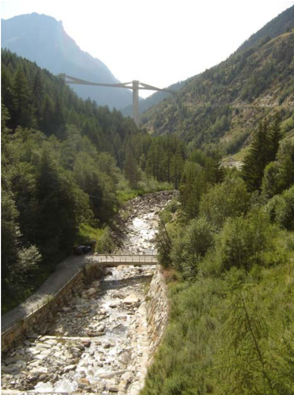
Ganterbach unterhalb der Fassung (2006)
