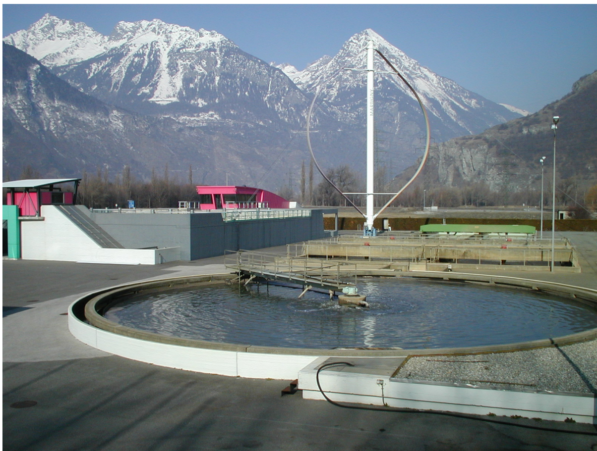
Station d'épuration de Martigny
