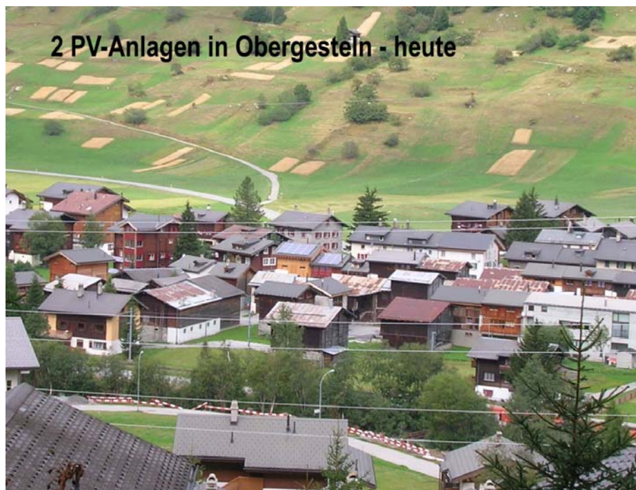
Partie du village vue du sud, avec les deux installations PV
