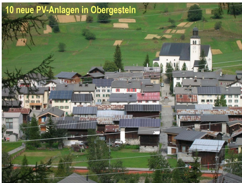
Photomontage avec 10 installations PV recouvrant toute la toiture
