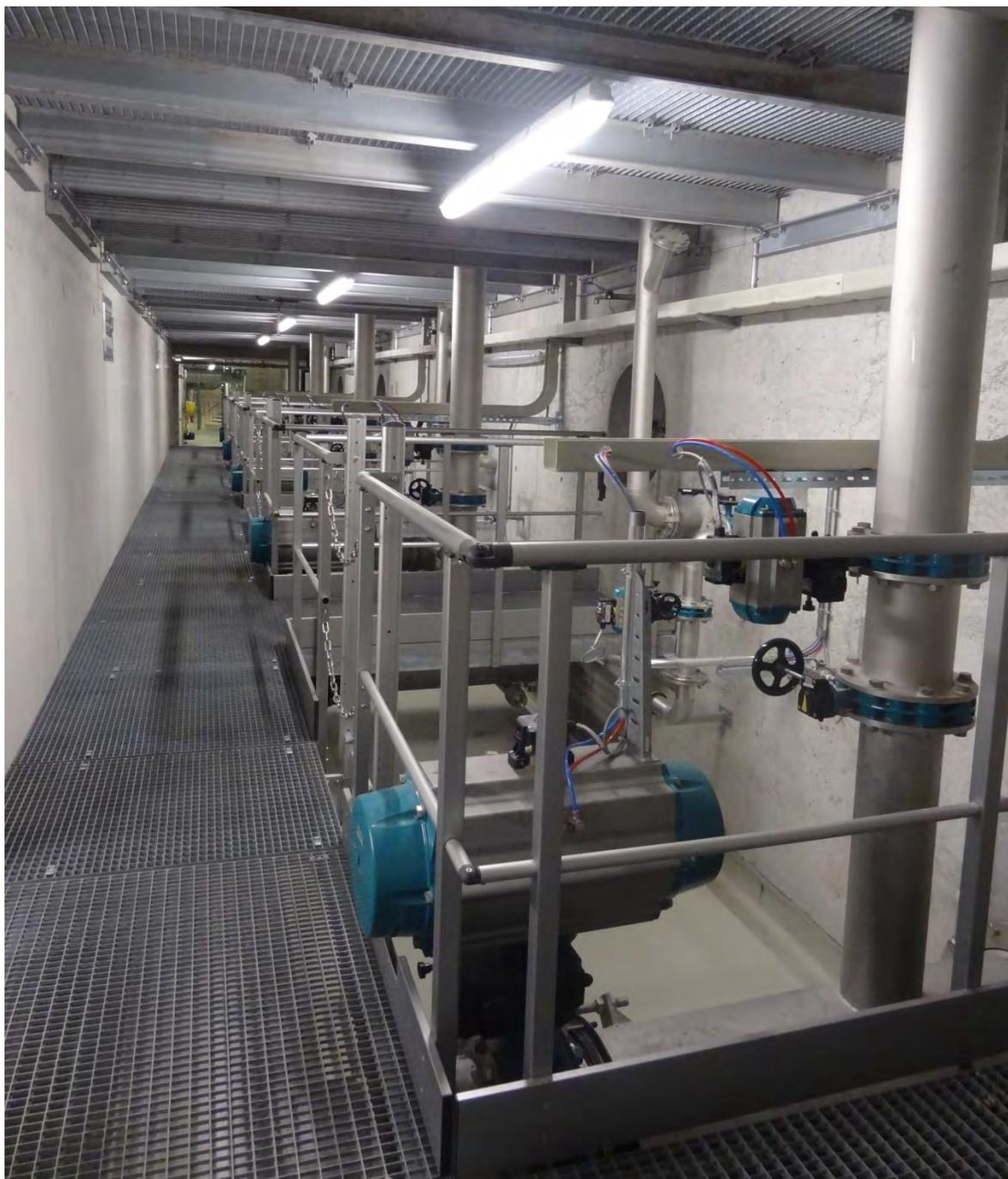
Figure 13 : STEP Bagnes-Le Châble : biofiltres pour la nitrification
