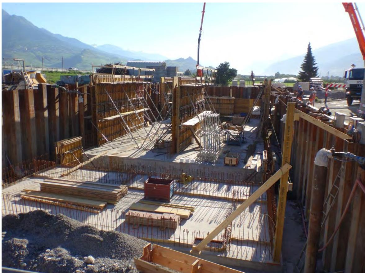
Figure 4 : STEP Vétroz-Conthey – Bétonnage voiles du décanteur primaire (juillet 2016)
