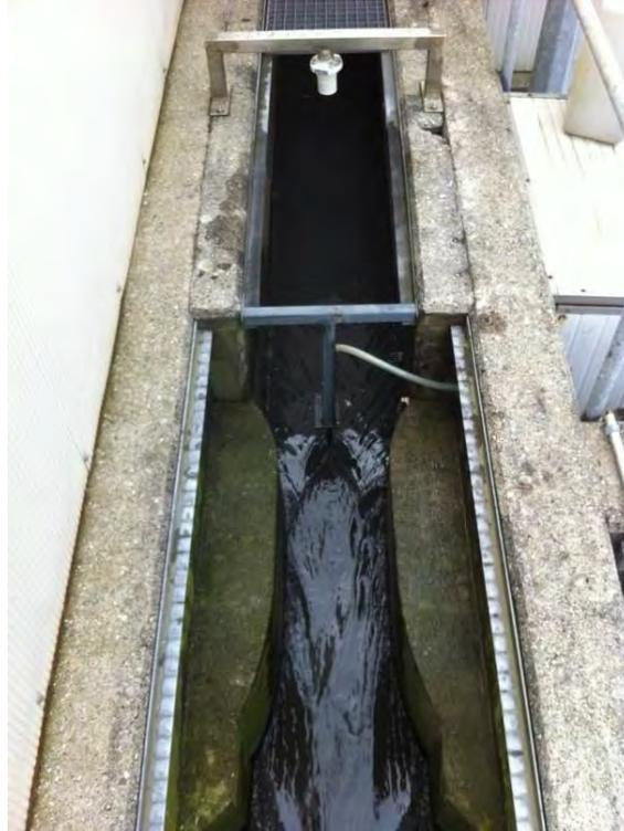
Figure 8 : Débitmètre Venturi entrée STEP Collombey-Muraz
