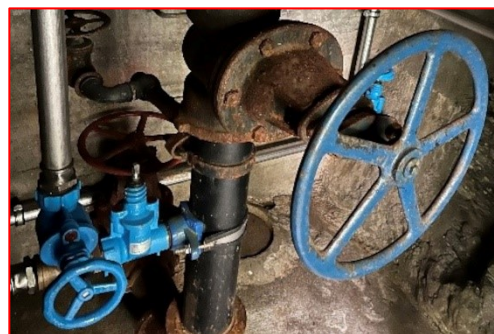
15 : Undichtiges Ventil - Feuerrreserve. © DSVS
