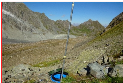
20 : Captage d'eau en haute altitude. © SCAV
