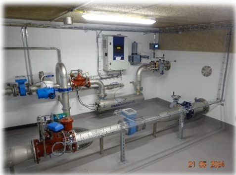
5 : Désinfection de l'eau à l'aide d'une lampe UV. © SCAV
